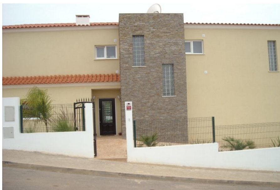
Figura 5.2 - Fachada principal (alçado Norte)
