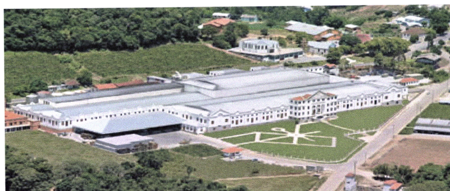
FIGURA A.14. Instalações da Vitivinícola Salton/RS
