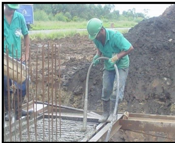
Figura 2.10 – Compactação com vibrador de agulha [12]
