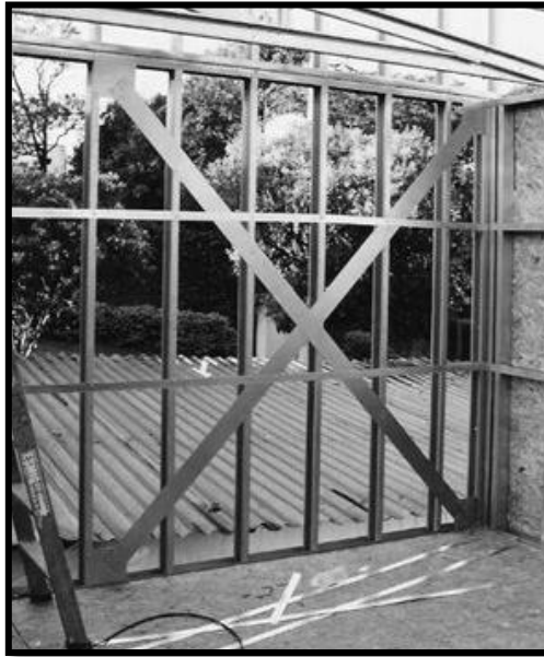
Figura 2.15 – Contraventamento em “X” [20]
