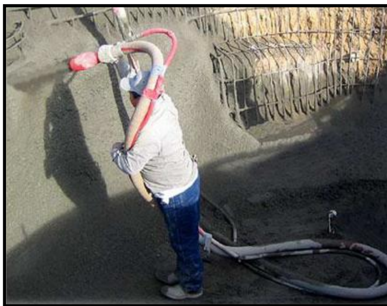
Figura 2.8 – Betonagem por projeção [10]
