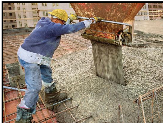
Figura 2.9 – Betonagem por deposição [11]
