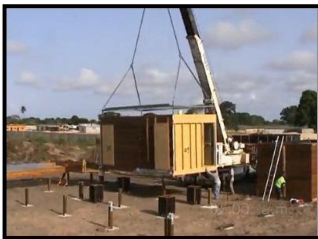
Figura 2.40 – Colocação de um módulo em obra [30]
