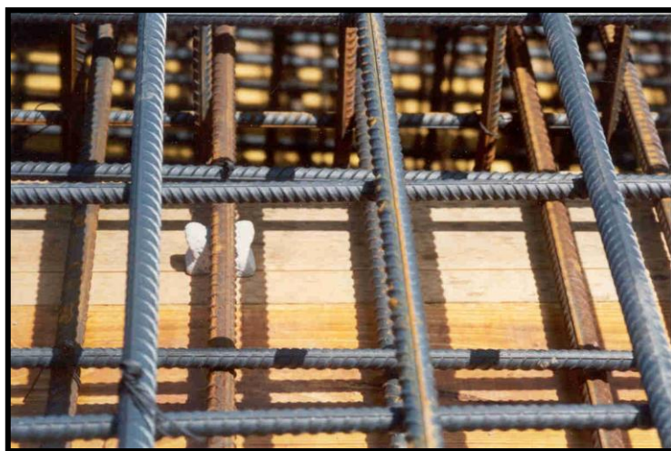
Figura 2.6 – Espaçador pré-fabricado em betão [8]
