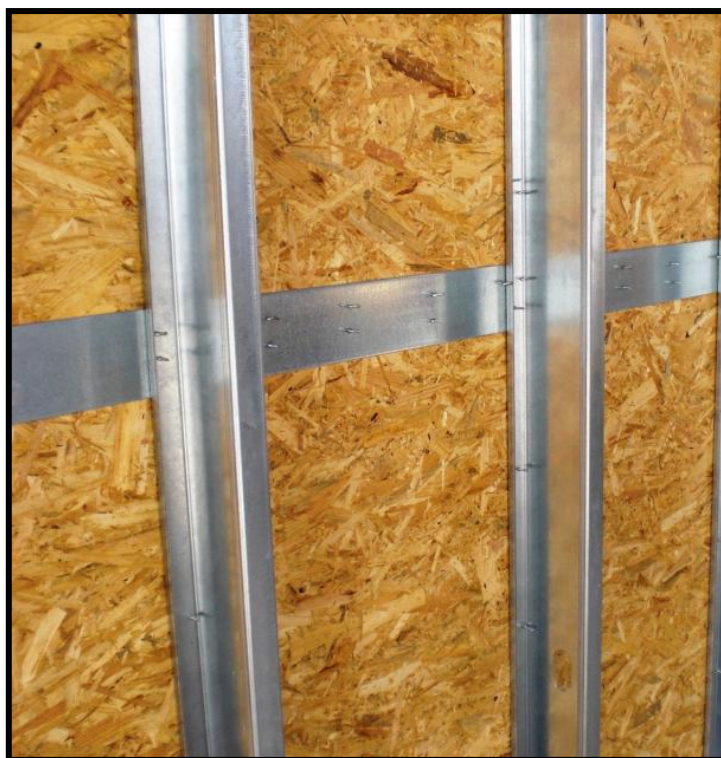
Figura 2.20 – Pormenor de revestimento estrutural [14]
