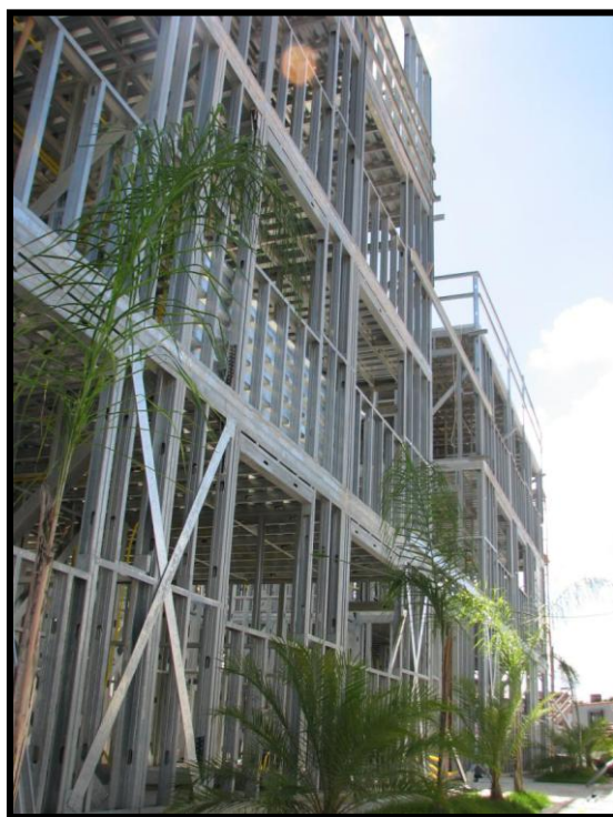
Figura 2.1 - Sistema construtivo em Light Steel Framing [4]
