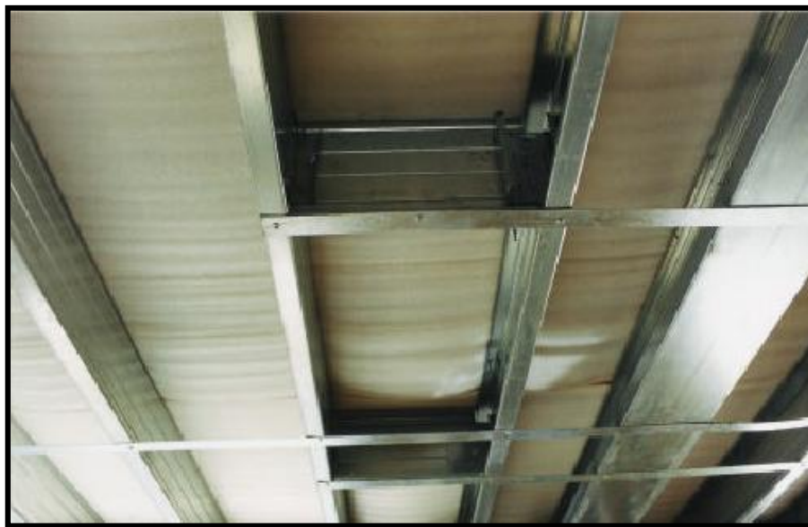
Figura 2.18 – Travamento horizontal da laje [20]
