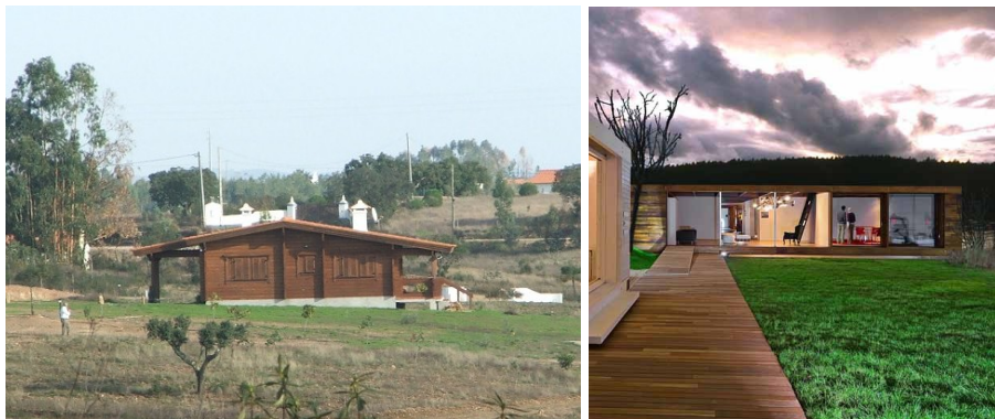
Figura 51. Duas construções de madeira pré-fabricadas. Covões, Avis e Modular System 274 .
