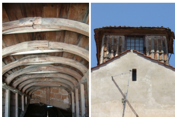
Figura 30. Trapeiras – vista da estrutura interior e vista exterior; Avis e Castro de Aire.
