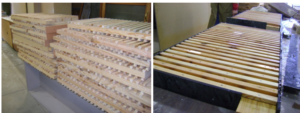
Figura 53. Painéis sem a argamassa e humedecimento da estrutura, antes da aplicação das argamassas.
