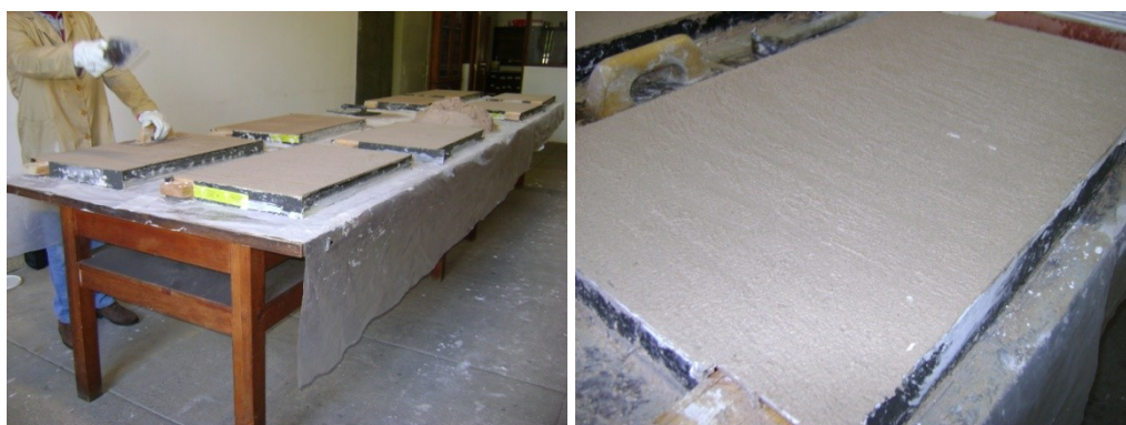
Figura 55. Aplicação de argamassa na estrutura de madeira.
