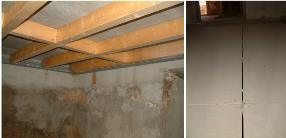
Figura 69. Exemplo de utilização de pavimento em painéis de madeira-cimento sobre estrutura de madeira; neste sobre o painel vai ser aplicado um revestimento final cerâmico.
