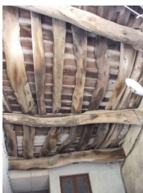
Figura 34. Vista inferior de estrutura de pavimento.
