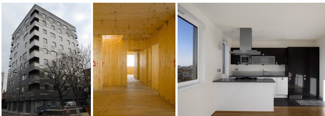
Figura 49. Imagens do edifício de madeira em altura do gabinete Waugh Thistleton, imagem do interior durante as obras e aspeto final interior 268 .
