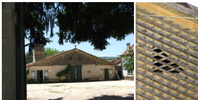
Figura 20. Vista do imóvel e pormenor, Travanca, Armamar.
