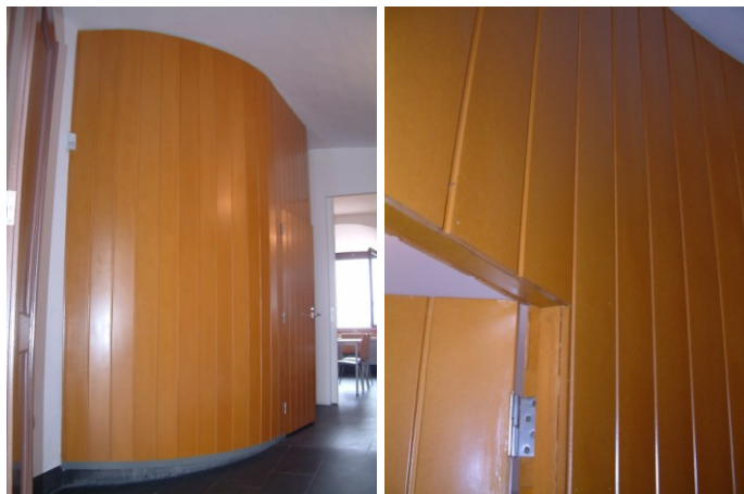
Figura 70. Introdução de uma instalação sanitária com recurso a paredes divisórias executadas com MDF colorido, que se destaca do espaço branco.
