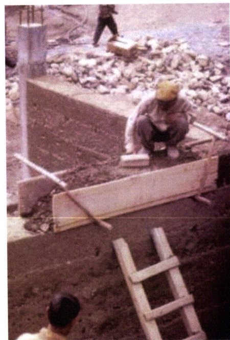
FIG. III.62 - ÍNDIA – Himachal Pradesh, Losar – apisoamento da terra com um tijolo.
