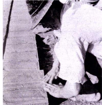
FIG. III.88 – Alisamento do bloco
