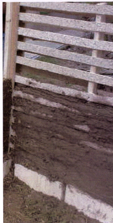
FIG. III.110 e III.111 - ESPANHA – Segóvia – Experiência de utilização da terra sobre engradado laminar em madeira 43
