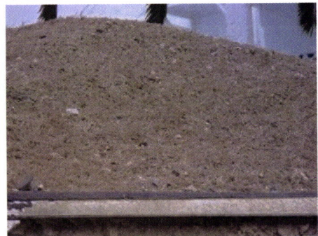
FIG. III.105 - PORTUGAL – Porto Santo – Vista em pormenor da cobertura de salão.
