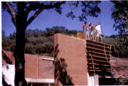
FIG. III.63 - E.U.A. – Califórnia, – apisoamento da taipa com recurso a vibradores e compressores 24
