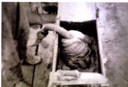
FIG. III.52 - Em cima – NOVA ZELANDIA – Aplicação da terra plástica segundo as técnicas do betão.
