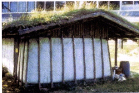
FIG. III.56 - ALEMANHA – Kassel – aplicação da terra de enchimento com membrana externa e outra interna, suportada pela paliçada vertical, fixada no solo e garrotada na parte superior.
