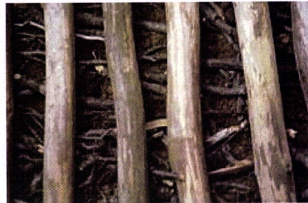
FIG. III.57 - ISLÂNDIA – Aspecto da utilização da turfa como terra de enchimento, na vertente interior da habitação. 21
