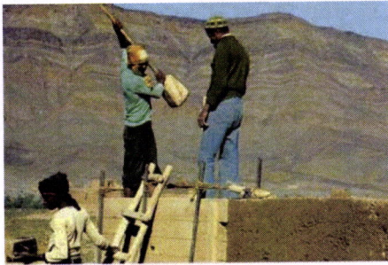
FIG. III.59 - MARROCOS – Norte de Atlas – apisoamento da taipa 23
