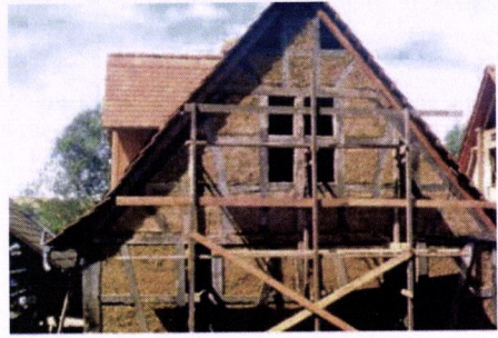
FIG. III.48 - ALEMANHA – Darmstadt – terra palha (não estrutural) aplicada nos paramentos exteriores.
