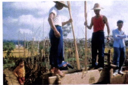
FIG. III.60 - CHINA – apisoamento com pilões em cunha (para as zonas de cantos e arestas)
