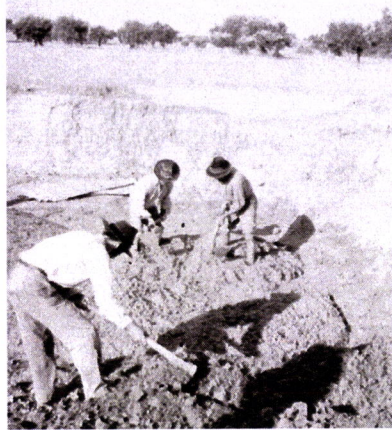
FIG. III.83 – Extracção da Terra
