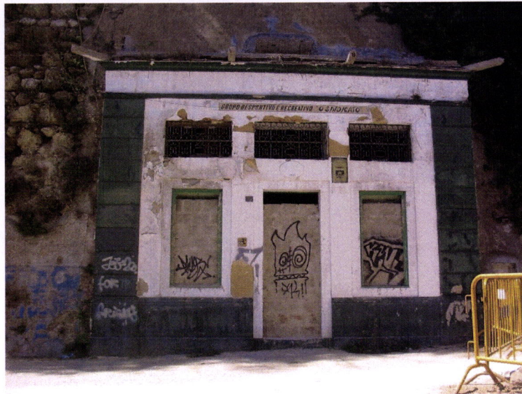
FIG. III.12 - PORTUGAL – Setúbal – Clube recreativo “o Sindicato”. Exemplo de remate da gruta com o exterior através da construção de uma fachada que lhe retire esse aspecto. Neste caso em análise, a par da fachada também foi construída a parede de um baluarte da Cerca Fernandina da cidade de Setúbal.
