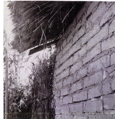
FIG. III.90 Aspecto de uma construção em Águas de Moura recorrendo ao Adobe.
