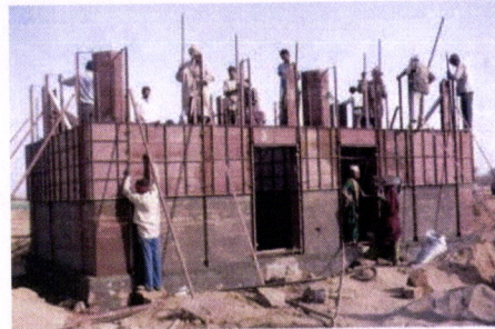
FIG. III.64 - ÍNDIA – Gujarat – Utilização de taipais metálicos como cofragem.
