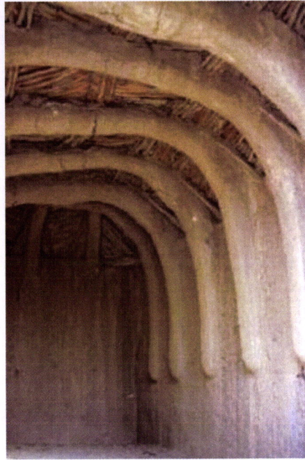
FIG. III.102 - NÍGER – Boncoucou – Terra de recobrimento de uma estrutura.
