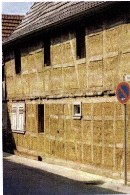
FIG. III.49 - ALEMANHA – Hessen, Gross Gerau – aspecto de uma parede exterior utilizando a terra-palha.
