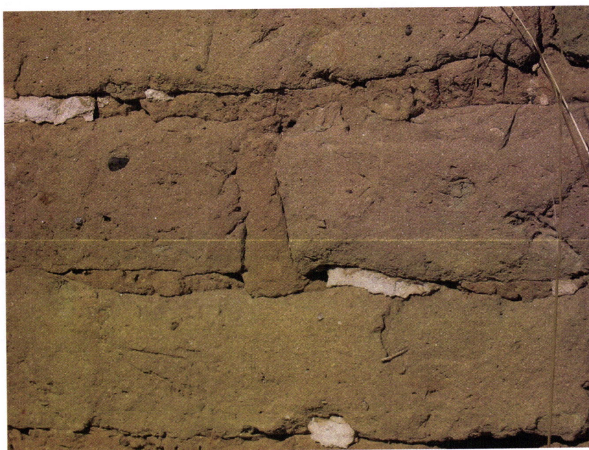
FIG. III.81 - PORTUGAL – Setúbal, Brejos de Azeitão – pormenor de uma parede construída em adobe.
