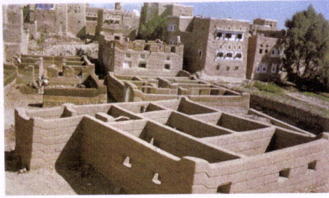
FIG. III.44 - Em cima - IEMENE DO SUL – Saadā – Terra empilhada em torrões. Construção típica (1976) 15
