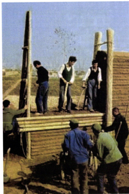
FIG. III.61 - CHINA – Região de Xiang – a utilização do taipal é substituída por troncos de madeira empilhados entre si.
