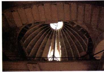
FIG. IV.118– PORTUGAL – Alfanzina 27 Cúpula Nervurada sobre pendentes com base octogonal em construção.
