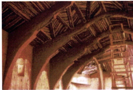
FIG. III.100 - NIGÉRIA – construção com terra reforçada 39
