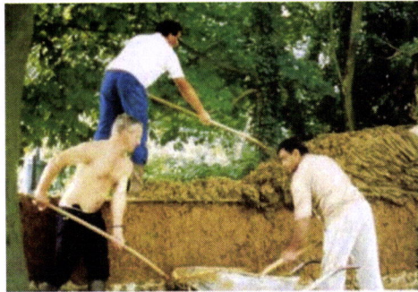
FIG. III.36 - FRANÇA – Picardie – Terra simplesmente empilhada 12
