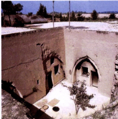
FIG. III.14 – CHINA – Nxiang – Aspecto de um pátio escavado, originador de acessos a habitações escavadas na terra. Salienta-se o aspecto das entradas que foram trabalhadas de forma a atenuar o aspecto de gruta. 6
