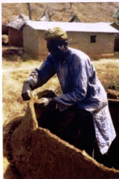
FIG. III.21 – NIGÉRIA – Joss – Construção de um silo em terra moldada. 9
