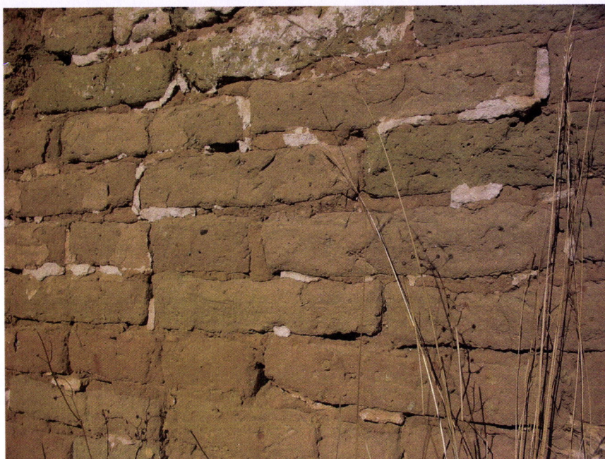
FIG. III.82 - PORTUGAL – Setúbal, Brejos de Azeitão – cada bloco tem uma face aparente de 40 cm x 7cm. Numa demolição de uma habitação contígua, constatou-se que os blocos eram quadrados (0.4 x 0.4 x 0.07)
