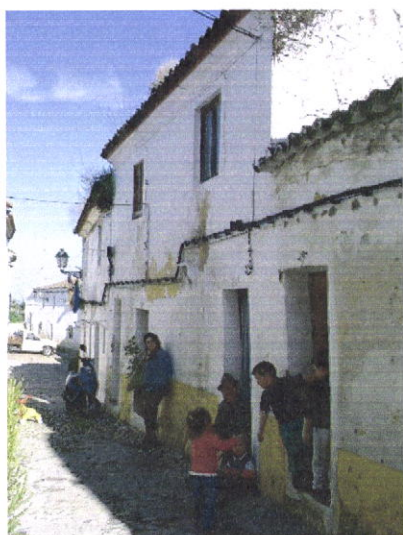
Fig. 5.9 e 5.10 – Edifícios na Rua das Beatas sem cunhal e edifício nas Portas do Sol com cunhais em pedra (fotos do autor)
