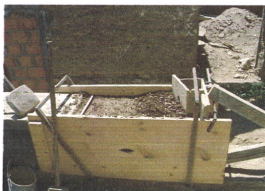
Fig. 7.11 e 7.12 – A terra a ser batida com o pilão e taipal preenchido.
