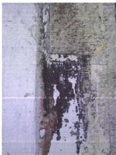
Fig. 7.22 e 7.23 – Argamassa a simular pedra com revestimento de superfície e argamassa a simular pedra. Rua Martim Mendes. (fotos do autor)
