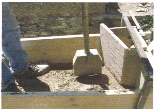
Fig. 7.11 e 7.12 – A terra a ser batida com o pilão e taipal preenchido.
