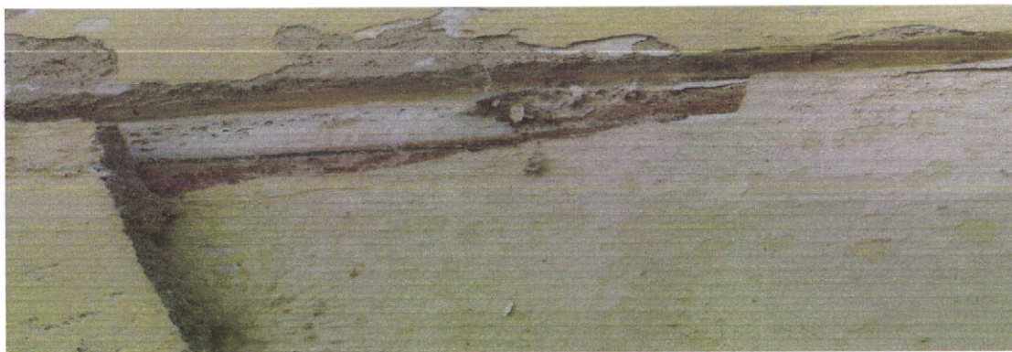
Fig. 7.25 – Edifício em que o esgrafito foi revestido com uma camada de reboco. Rua Martim Mendes. (foto do autor)
