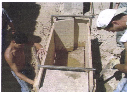
Fig. 7.9 e 7.10 – Montagem do taipal e aplicação dos costeiros e da agulha.
