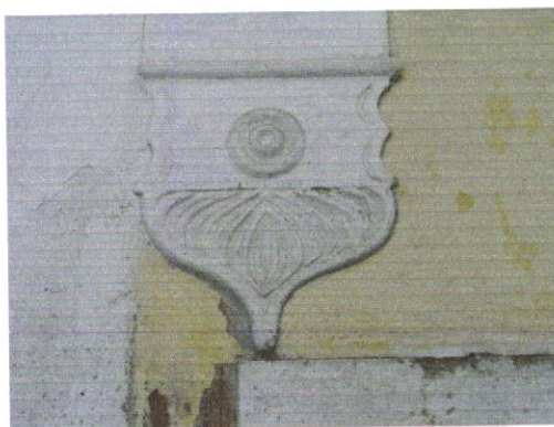
Fig. 7.26 e 7.27 – Guarnecimentos nas molduras de vãos e guarnecimento de um cunhal. Rua Martim Mendes. (fotos do autor).
