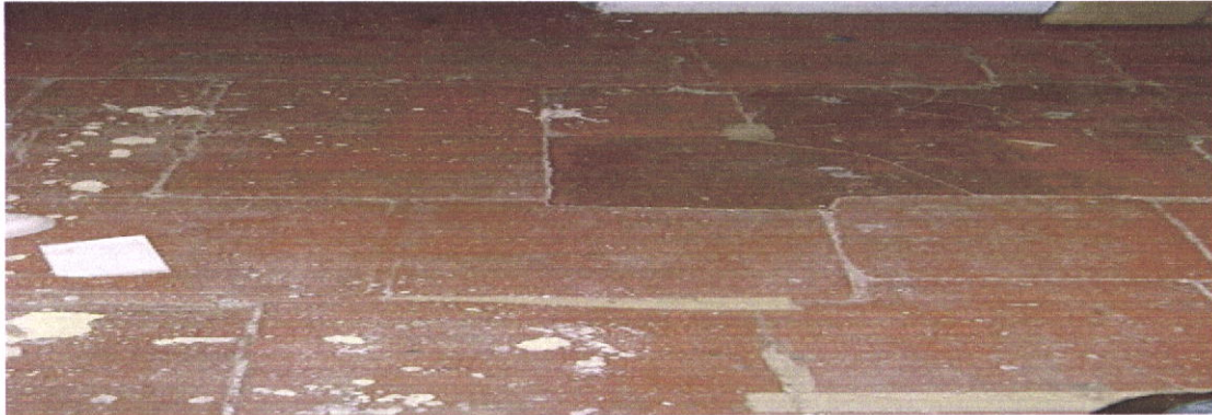
Fig. 7.3 – Baldosa utilizada em pavimento Rua das Beatas. (foto do autor)
