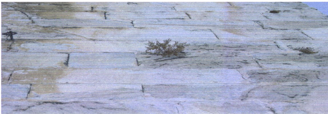
Fig. 7.18 – Fachada da Igreja Nossa Sr.ª da Assunção construída em blocos de quartzito (foto do autor).
