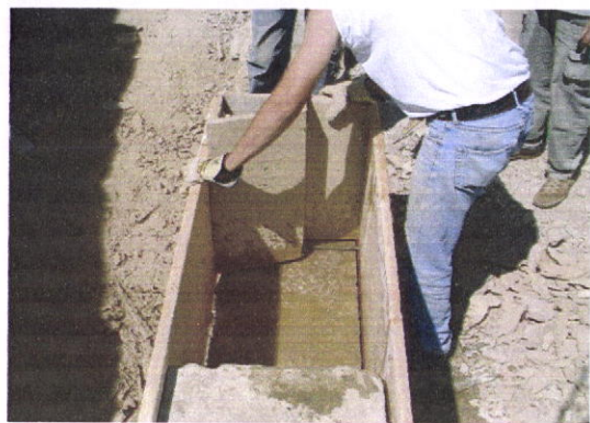
Fig. 7.9 e 7.10 – Montagem do taipal e aplicação dos costeiros e da agulha.
