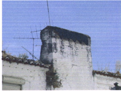
Fig. 5.23 e 5.24 – Chaminés da Rua Martim Mendes (fotos do autor)
