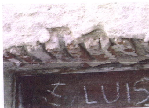
Fig. 7.5 e 7.6 – Tijolo burro utilizado na construção das paredes. Rua dos Açougues e Rua das Beatas. (foto do autor)
