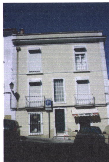
Fig. 5.9 e 5.10 – Edifícios na Rua das Beatas sem cunhal e edifício nas Portas do Sol com cunhais em pedra (fotos do autor)
