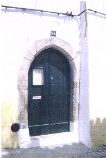
Fig. 7.16 e 7.17 – Utilização de granito na guarnição de uma porta e de mármore na soleira. Arco dos Pregos. Alvenaria constituída com vários tipos de pedra. Rua dos Açougues. (foto do autor).
