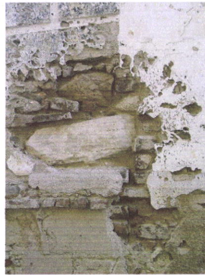
Fig. 7.16 e 7.17 – Utilização de granito na guarnição de uma porta e de mármore na soleira. Arco dos Pregos. Alvenaria constituída com vários tipos de pedra. Rua dos Açougues. (foto do autor).
