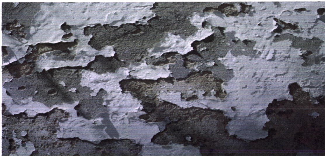
8.16 – A tinta branca a destacar-se da superfície de argamassa de cal com reintegrações com argamassa à base de cimento “Portland”. Rua das Beatas. (foto do autor)
