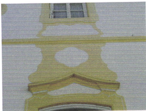
Fig. 7.26 e 7.27 – Guarnecimentos nas molduras de vãos e guarnecimento de um cunhal. Rua Martim Mendes. (fotos do autor).
