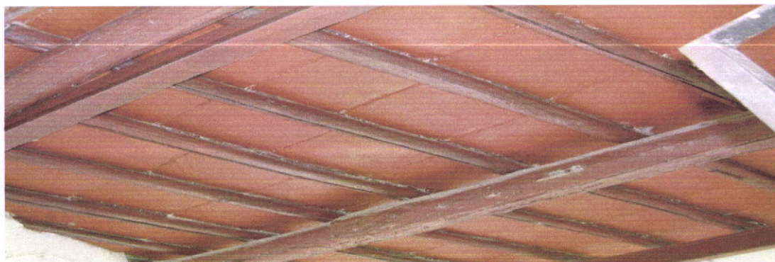
Fig.7.4 - Baldosa utilizada na definição de piso. Rua Martim Mendes. (foto do autor)
