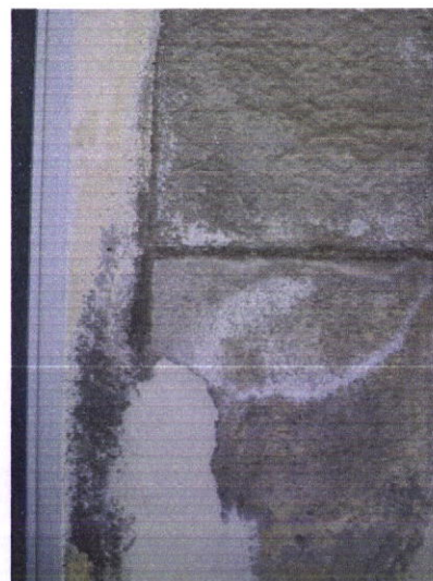
Fig. 7.22 e 7.23 – Argamassa a simular pedra com revestimento de superfície e argamassa a simular pedra. Rua Martim Mendes. (fotos do autor)
