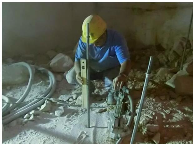
**Figura 5.15** – Verificação da verticalidade da barrena através da utilização do nível de bolha.
