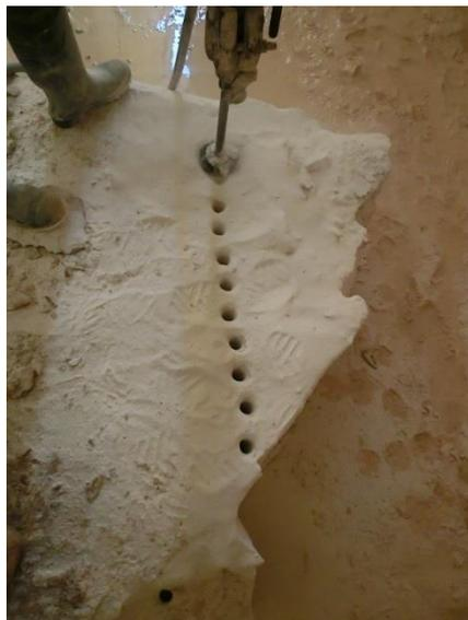
**Figura 5.47** – Realização dos furos da guilhação integral com recurso ao martelo pneumático.
