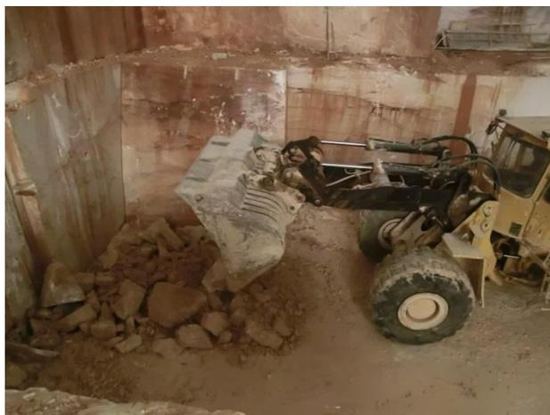
**Figura 5.39** – Realização da “cama” recorrendo-se à pá carregadora com o balde acoplado.
