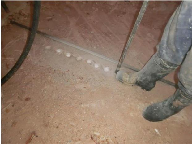
**Figura 5.50** – Realização do conjunto de pequenos furos paralelos à direção de perfuração (marcada pela barrena colocada no chão).
