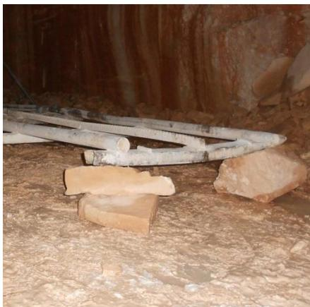
**Figura 5.20** – Nivelamento do carril com fragmentos de pedra.
