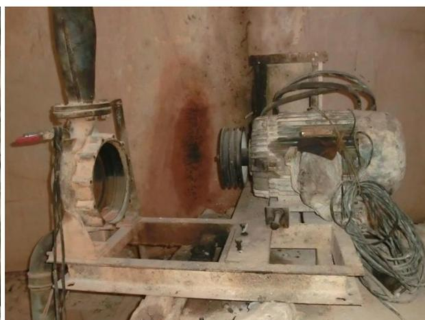
**Figura 4.37** – Bomba de água Siemens (com o veio de transmissão desmontado para reparação).
