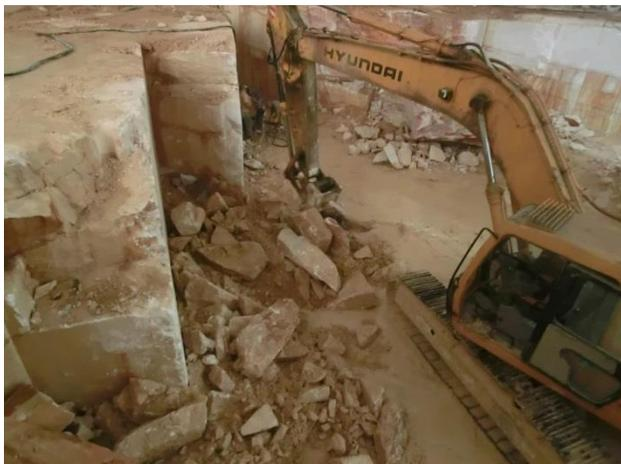
**Figura 5.61** – Utilização da escavadora de rastos na arrumação dos escombros.
