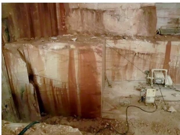
**Figura 7.5** – Execução do primeiro corte vertical.
