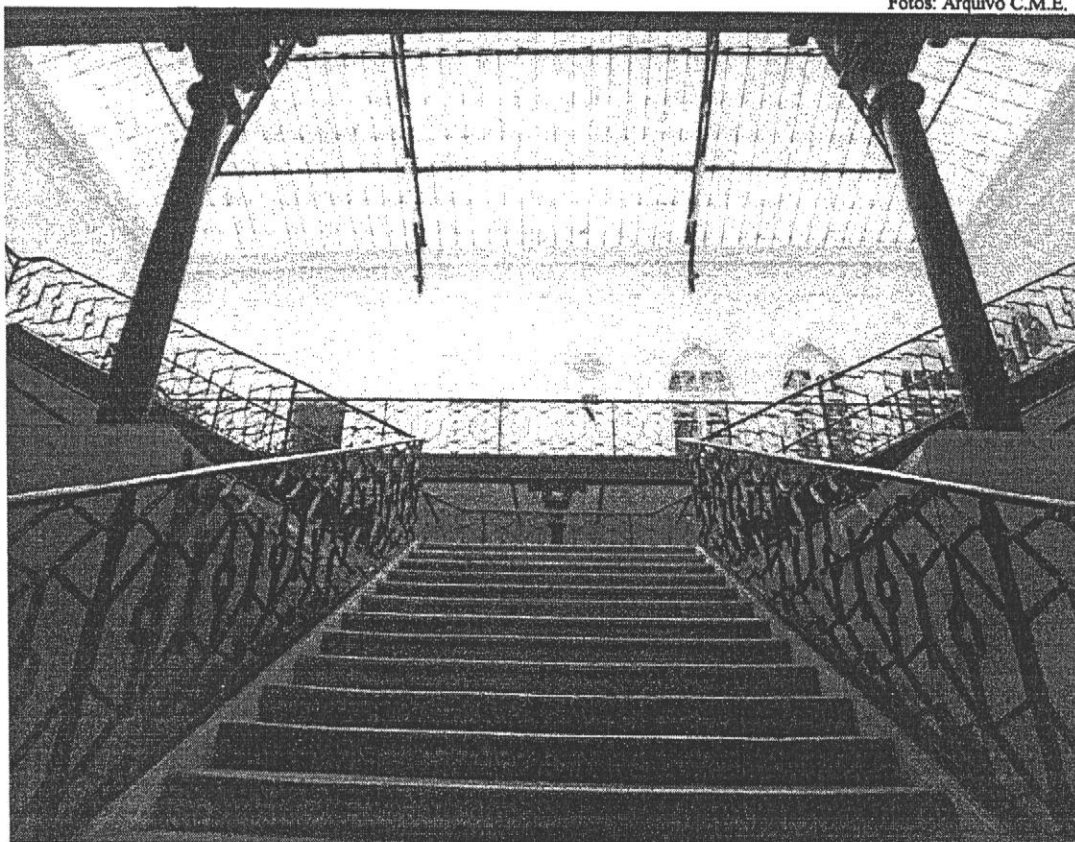
Anexo 16 – Utilização do ferro na “escadaria de honra” do corpo central do edifício dos Paços do Concelho.
