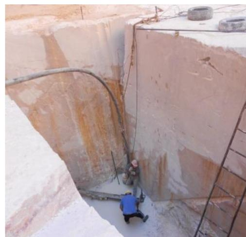
**Figura 4.68 – Caixa do abaixamento de piso com triângulo resultante do corte lateral, no comprimento da caixa.**
