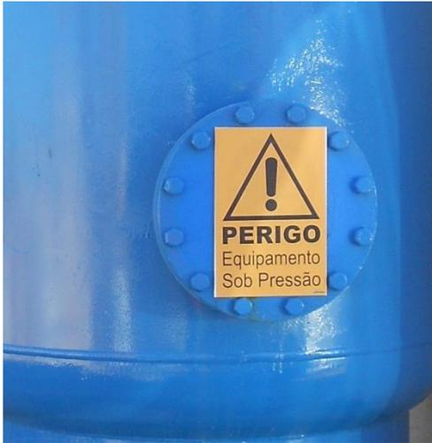
Figura 4.124 – Depósito de ar comprimido sinalizado com placa de perigo.
