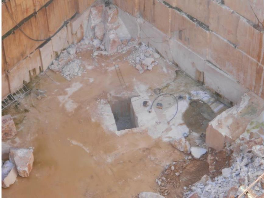
Figura 4.69 – Resultado final da caixa do abaixamento de piso.
