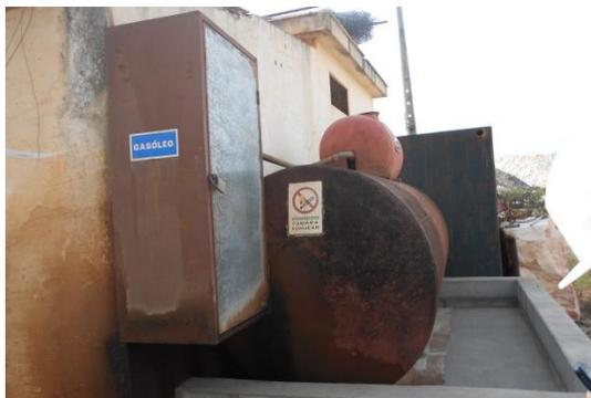
Figura 4.126 – Depósito de gasóleo com sinalização de identificação do local e de proibição de fumar ou foguear.
