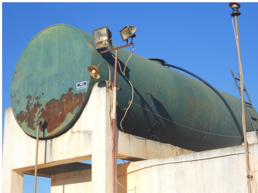
Figura 4.134 – Depósito de água não potável proveniente da cavidade após decantação.
