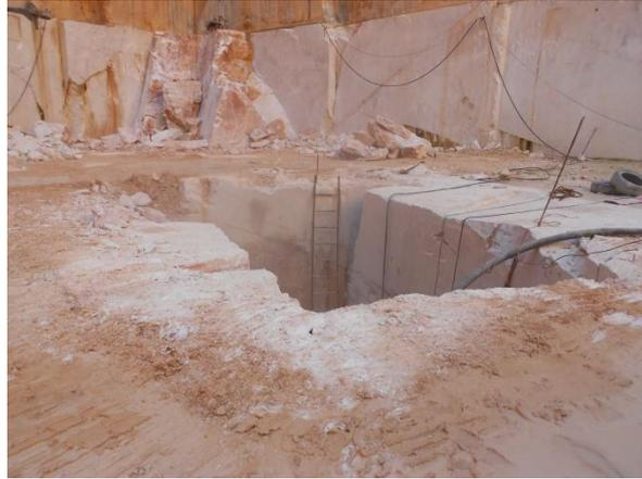
**Figura 4.70 – Aspeto inicial da operação de alargamento do abaixamento de piso.**
