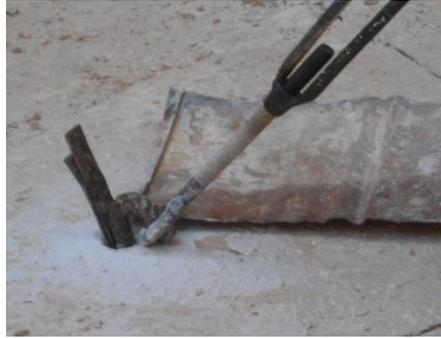
Figura 4.24 – Pormenor de fixação das espias com esticador, grampo, guilho e palmetas.
