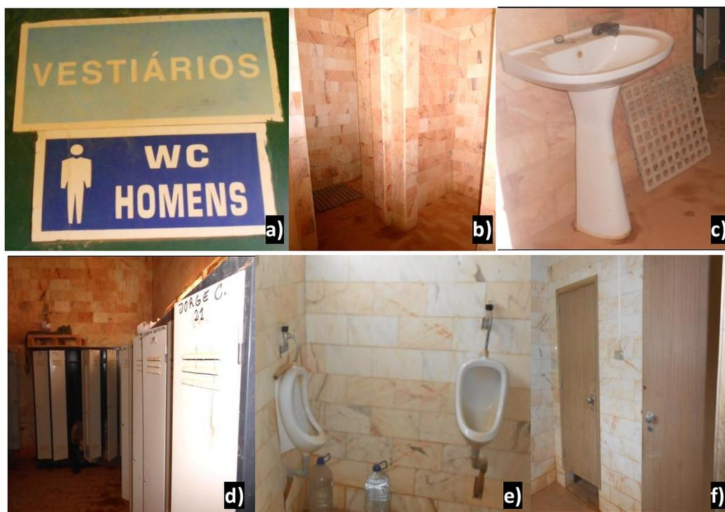
Figura 4.113 – a) Identificação do espaço físico; b) Chuveiros; c) Lavatório da zona de vestiário; d) Cacifos; e) Urinóis f) Casas de banho individuais.
