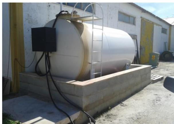
Figura 5.86 – Depósito de gasóleo.
