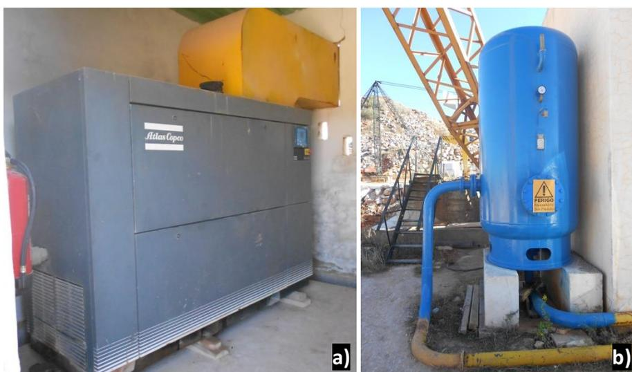
Figura 4.116 – a) Compressor; b) Depósito de ar comprimido.
