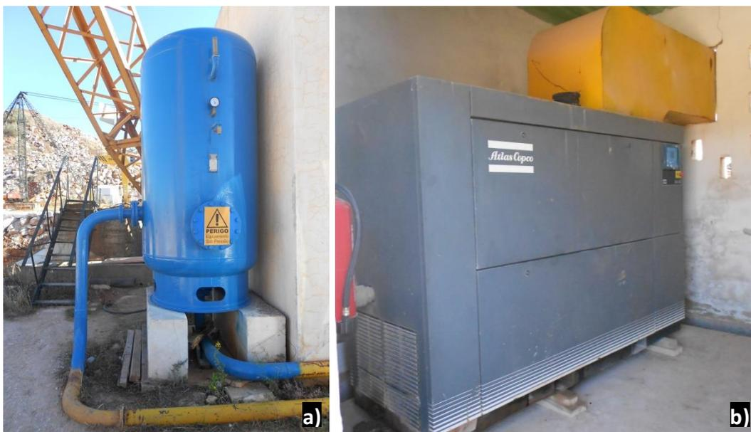
Figura 4.48 – Sistema de ar comprimido: a) depósito de ar comprimido; b) compressor.
