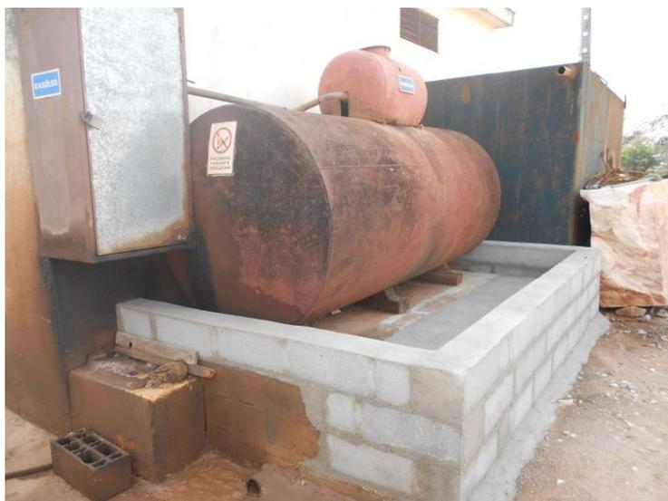
Figura 4.115 – Depósito de gasóleo devidamente identificado evidenciando a impermeabilização da zona.
