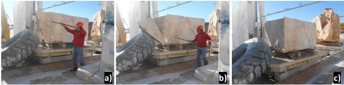
Figura 4.26 – Processo final de remoção de um chanfro: a) separação do chanfro com recurso a uma vara metálica com extremidade em cunha; b) separação do chanfro do bloco devidamente apoiado num pneu evitando-se a sua queda brusca; c) aspeto final do bloco.
