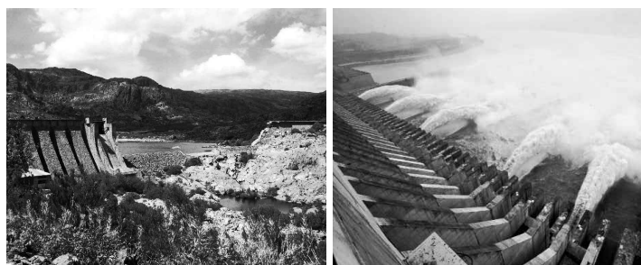
Fig. 17 e 18 Área envolvente à Barragem de Moncabril após desastre(1959) e Barragem das Três Gargantas (2006), respectivamente
