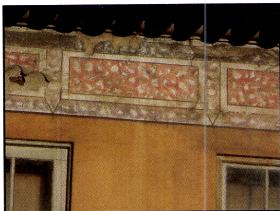
Fig. 84 – Celorico de Basto. Barreirós. Casa 1. Pormenor da pintura mural a imitar um marmoreado em dois tons.
