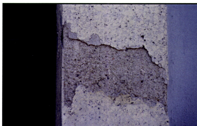
Fig. 132 - Mondim de Basto. Outro exemplo de um fingido de granito aplicado sobre um reboco de cimento, recorrendo à técnica de salpico de tinta, "dripping".
