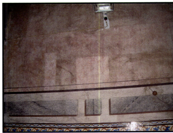
Fig. 185 – Igreja do Carmo. Viana do Castelo. Paramento em stucco-lustro , evidenciando acumulação de lixo e colonização biológica.
