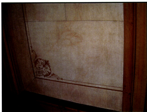
Fig. 161 -- Casa do Assento 2. Felgueiras. Parede em stucco-lustro . Note-se a elegância do desenho a estampilha.
