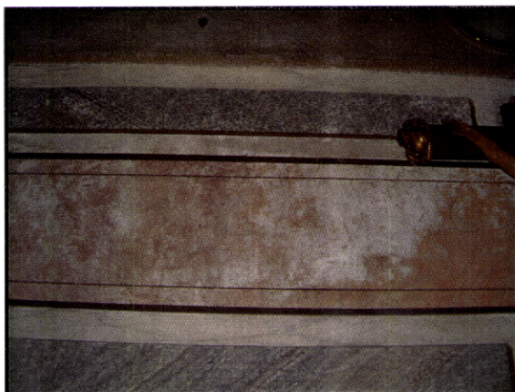
Fig. 187 – Igreja do Carmo. Viana do Castelo. Friso com camada cromática em destaque, comprovativo da aplicação de pintura a seco.
