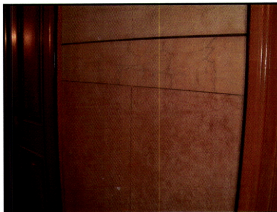
Fig. 183 – Casa Abreu Távora. Viana do Castelo. Trata-se do único paramento em stucco-lustro sobrevivente no edifício. Marmoreado fingido a fresco.
