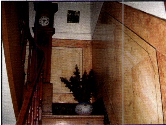
Fig. 164 – Casa do Pinheiro. Guimarães. Parede em stucco-lustro . O brilho evidencia uma técnica de acabamento a ferro quente e a cera.
