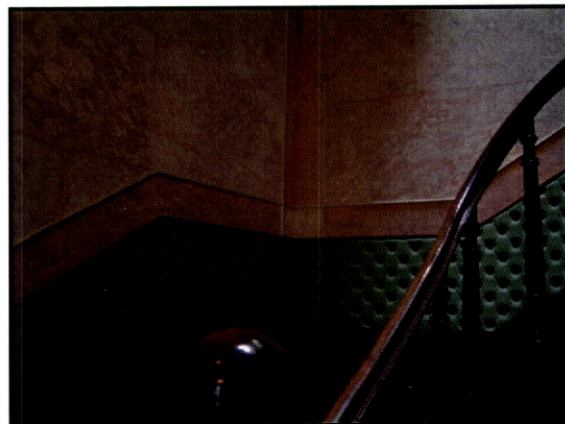
Fig. 141 – Palacete Abrunhosa. Viana do Castelo. Escada de acesso ao primeiro piso. As paredes em stucco-marmo . O fingido de veludo verde do lambrim, em estuque, imita na perfeição a textura de um revestimento estufado.
