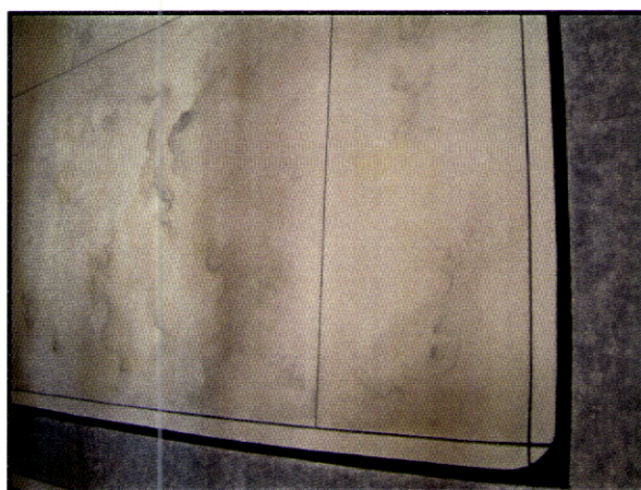
Fig. 151 – Casa do Barão. Cabeceiras de Basto. Plano da pintura a simular veios, no painel central do lambrim. Atente-se a que os veios da pedra são imitados como se se tratasse de silhuetas de nuvens.
