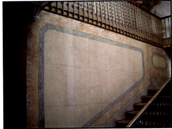
Fig. 172 – Rua de Camões, 108. Guimarães. São visíveis a esterotomia da pedra marcada com o estuque fresco e a patine da pintura.
