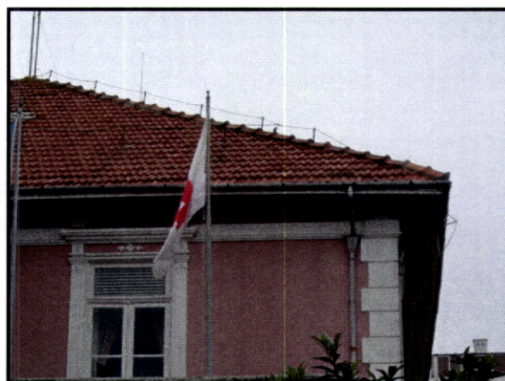
Fig. 105 – Chalé Arte Nova. Porto. Estuques decorativos no cunhal a simular pedra.
