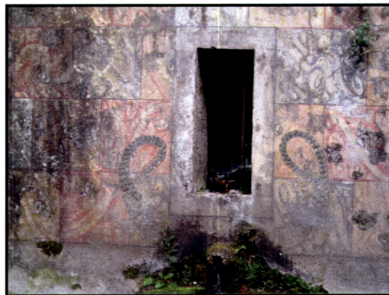
Fig. 87 Celorico de Basto. Arnóia. Fonte da Casa do Telhoa. Pormenor dos animais fantásticos. Visualiza-se o destacamento da camada de preparação da pintura, motivada pela migração de sais na parede.
