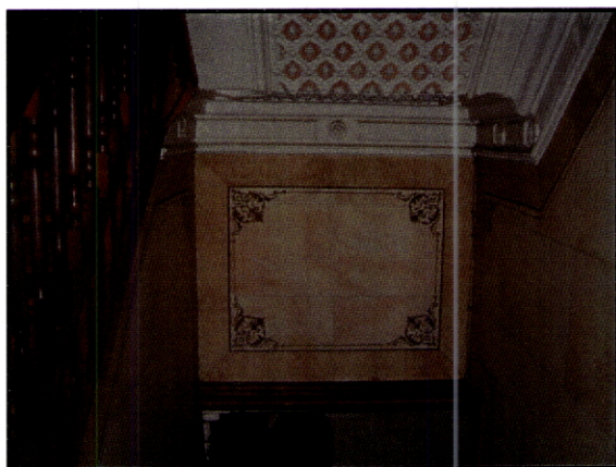
Fig. 159 – Casa do Assento 2. Felgueiras. Paredes de um vão de escada revestidas a técnica de stucco-lustro , com cercaduras pintadas a estampilha.
