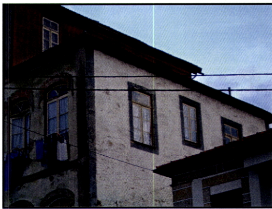
Fig. 114 – Celorico de Basto. Guarnecimentos com pó de sapato. Na fachada principal, as janelas do piso superior rematam com rebocos moldados a imitar tijolo.
