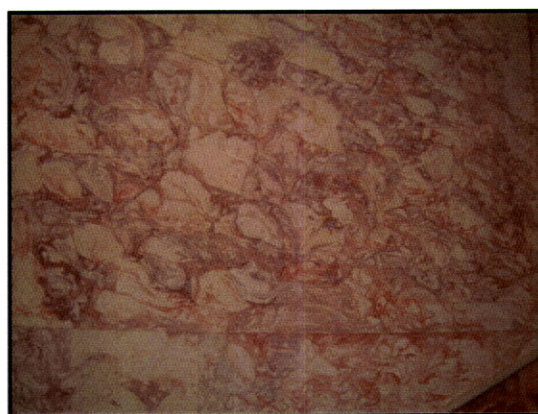
Fig. 142 – Palacete Abrunhosa. Viana do Castelo, pormenor de stucco-marmo da parede da escadaria de acesso ao primeiro piso.
