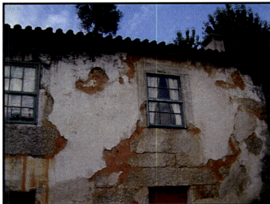
Fig. 112 – Quinta dos Machados. Celorico de Basto. Séc. XIX. Fachada revestida a reboco de cal, onde se visualizam guarnecimentos simulando cantarias. A alvenaria de pedra está revestida por uma invulgar argamassa de terra, muito grosseira, para isolamento.
