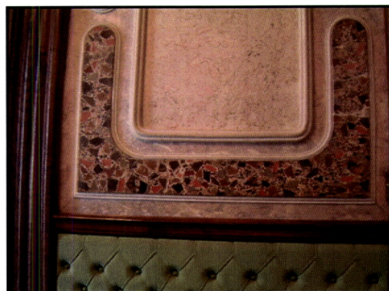
Fig. 140 – Palacete Abrunhosa. Viana do Castelo. Hall da entrada do edifício. Simulações de mármore e de brecha da Arrábida em stucco-marmo . Lambrim verde, com uma simulação de veludo em estuque.
