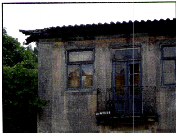
Fig. 115 - Veade. Celorico de Basto. Na fachada principal há vestígios de um remate de pilastra pintado, do lado esquerdo. São ainda evidentes os guarnecimentos a fingir cantaria.
