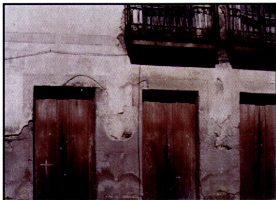
Fig. 111- Casa 2 de Barreirós. Celorico de Basto. Séc. XIX. Fachada principal com guarnecimentos a simular cantarias. A barra horizontal representa uma pormenor decorativo que anima a fachada, e a divide em dois planos.
