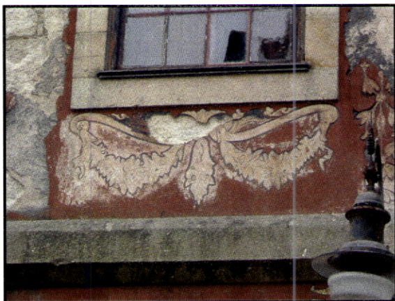
Fig. 119 – Teatro-Cinema de Fafe. Pormenor do reboco de cal que ainda subsiste.
