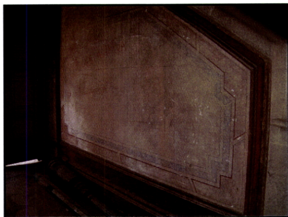
Fig. 145 – Casa de Eiró de Baixo. Mondim de Basto. Marmoreado em stucco-lustro . Pormenor de moldura pintada com gregas.
