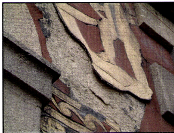
Fig. 122 - Teatro-Cinema de Fafe. Pormenor da parte superior da fachada. A pintura de base está representada por um tom escuro (avermelhado), sobre o qual foi aplicado o tom mais claro, simulando como que um negativo de uma camada inferior. As duas camadas cromáticas estão em destaque, em virtude da falta de coesão e adesão do revestimento asfáltico e do reboco de cal.
