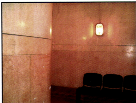
Fig. 182 – Casa Abreu Távora. Viana do Castelo. Parede de corredor em stucco-lustro .
