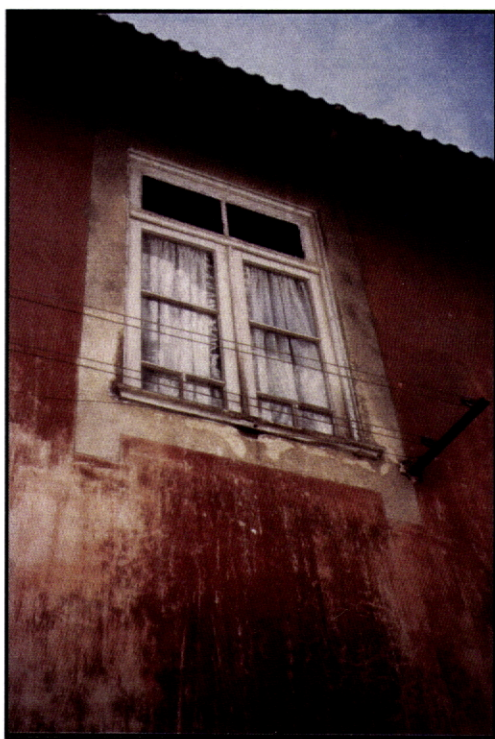
Fig. 98 – Mondim de Basto. Cantaria de janela fingida. Sobre a parede foi aplicada uma tinta à base de cal e de óxido de ferro.
