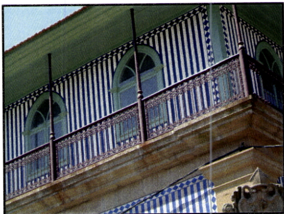
Fig. 76 - Casa do Barão. Cabeceiras de Basto. Acréscimo construído no séc. XIX.
