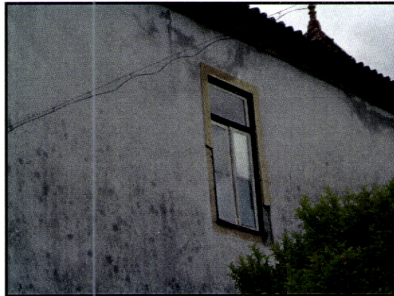
Fig. 102 – Mondim de Basto. Cantaria de janela fingida em argamassa moldada.
