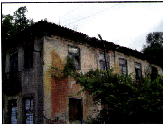
Fig. 116 - Veade. Celorico de Basto. Fachada lateral da mesma casa. São nítidas as diversas pinturas à base de pigmentos minerais (óxido de ferro), destacando-se o vermelho e o ocre.
