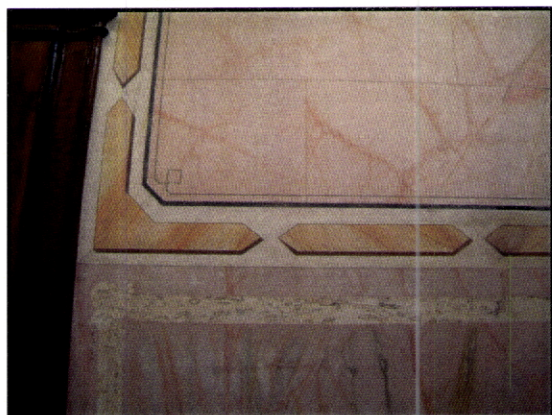
Fig. 190 – Palacete Abrunhosa. Viana do Castelo. Paramento em stucco-lustro emoldurado por pintura a seco. A parte inferior do lambrim simula outro tipo de marmoreado.
