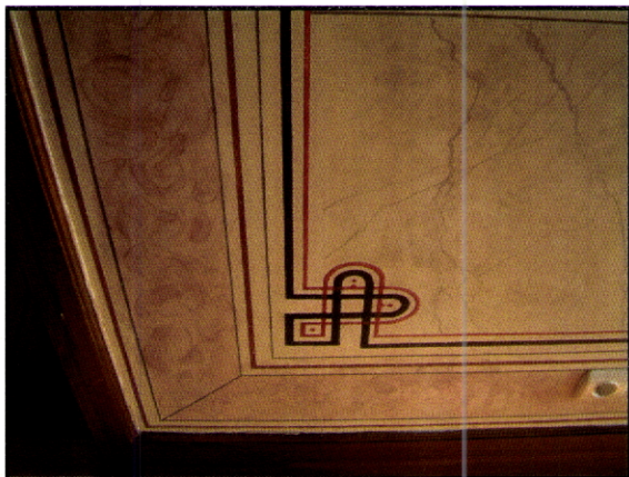
Fig. 147 – Casa do Barão. Cabeceiras de Basto. Parede revestida em stucco-lustro , pintada a estampilha.
