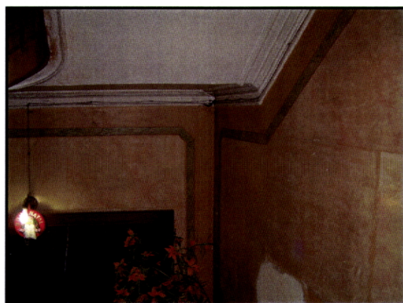
Fig. 169 – Rua de Camões, 108. Guimarães. Vão de escada com paramentos marmoreados. A mancha mais clara corresponde a uma consolidação dos estuques da parede.
