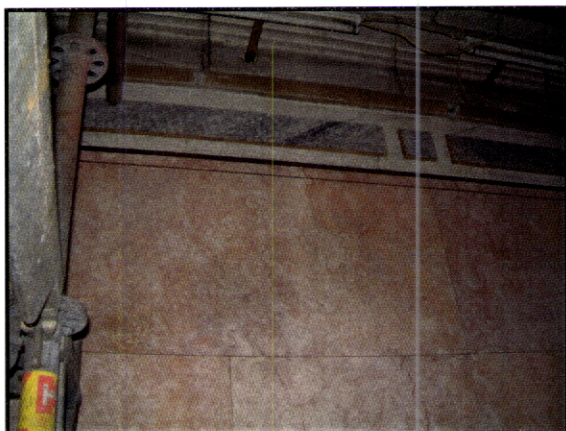
Fig. 186 – Igreja do Carmo. Viana do Castelo. Paramento após a limpeza com biocida.
