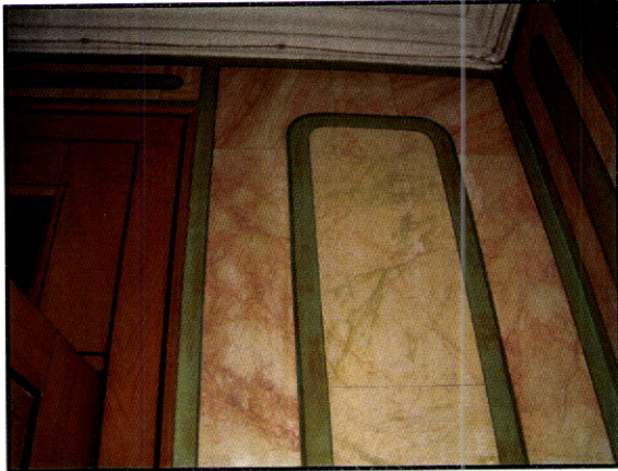
Fig. 171 – Rua de Camões, 108. Guimarães. Marmoreado em stucco-lustro . As mudanças de plano são acentuadas pelas molduras pintadas.
