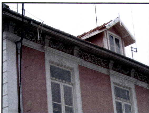
Fig. 106 - Chalé Arte Nova. Porto. Pormenor dos estuques decorativos no vão da cornija com grinaldas e volutas.
