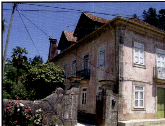
Fig. 110 – Casa de Tojais. Celorico de Basto. Séc. XIX. A fachada principal possui cantaria verdadeira. Na fachada lateral, todas as janelas e portas exibem guarnecimentos imitando cantarias.
