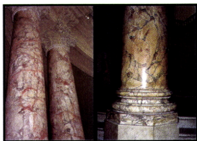
Fig. 50 – Colunas fingidas em stucco-marmo de autoria italiana. Centro Galego. Havana, Cuba. (I.Gárate Rojas, Arte de los Yesos , Madrid, Munila-Léria, 1999, p. 125).
