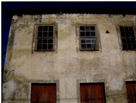
Fig. 109. – Casa do Juiz José Machado. Fermil. Celorico de Basto. Séc. XIX. Fachada principal com guarnecimentos a fingir cantaria.
