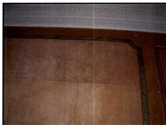
Fig. 170 – Rua de Camões, 108. Guimarães. Pormenor de uma parede em stucco-lustro com moldura pintada a óleo, a seco.
