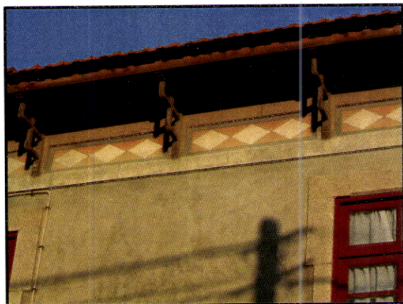
Fig. 82 – Vilar do Pinheiro. Mosteiro. Casa 1. Friso a imitar azulejo em pintura mural. Face conservada.
