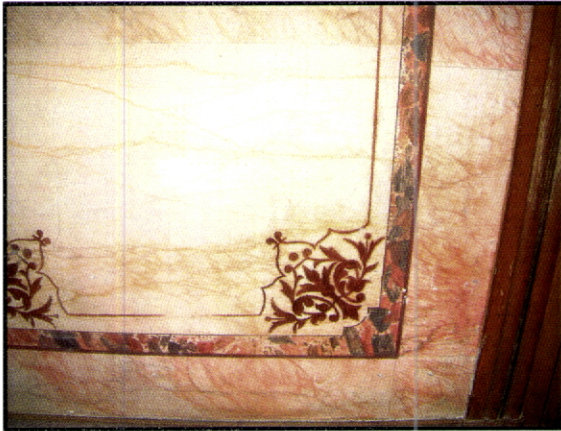
Fig. 163 – Casa do Outeiro. Guimarães. Parede fingida em mármore. A cercadura exibe uma pintura a seco que simula de modo grosseiro brecha.
