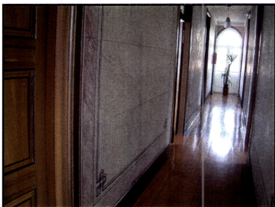
Fig. 149 – Casa do Barão. Cabeceiras de Basto. Corredor do piso superior com paramentos a exibirem marmoreados originais em stucco-lustro .
