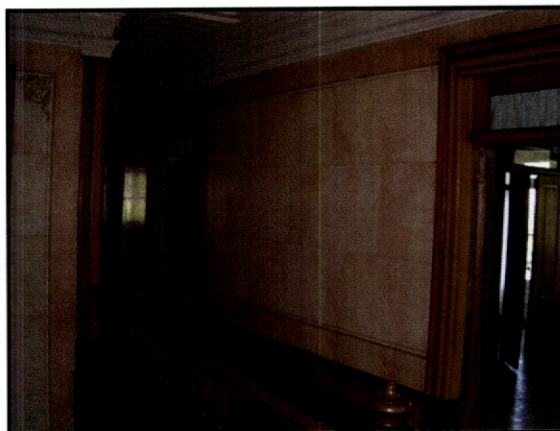
Fig. 162 – Casa do Assento 2. Felgueiras. Parede em stucco-lustro , brunida provavelmente a ferro quente e acabada a cera.
