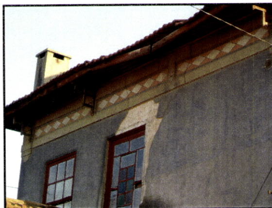
Fig. 83 – Vilar do Pinheiro. Mosteiro. Casa 2. Outro friso a simular azulejo. No canto superior direito vê-se um elemento decorativo em reboco que remata o cunhal.
