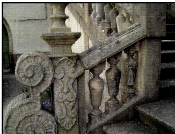
Fig. 97 - Casa de Eiró de Baixo. Mondim de Basto. Escadaria de acesso ao primeiro piso. Note-se o contraste entre os ornatos em pedra e os ornatos fingidos em argamassa.
