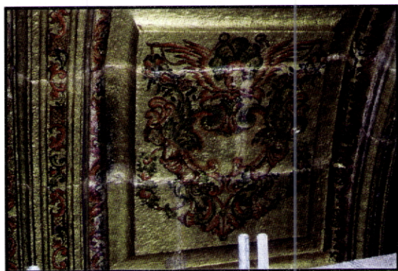
Fig. 75 - Colégio de S. Lourenço.(Igreja dos Grilos) Porto. Note-se o aparecimento das juntas de granito sob a pintura a óleo. Para a execução da pintura apenas deve ter sido executado um ligeiro reboco de regularização da superfície pétrea. 372
