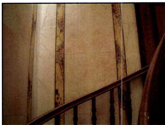
Fig.188 – Palacete Abrunhosa. Viana do Castelo. Parede em stucco-lustro , com friso decorativo pintado a óleo e a seco.
