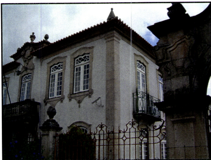
Fig. 93 – Casa de Eiró de Baixo. Mondim de Basto. Fachada principal barroca com elementos em cantaria.
