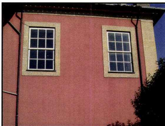
Fig. 130 – Casa da Praça. Celorico de Basto. Exemplo de uma má recuperação, na qual o edifício de alvenaria tradicional foi integralmente rebocado a cimento.
