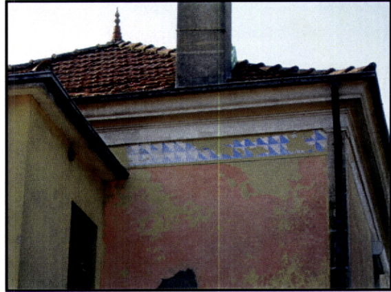
Fig. 80– Paredes de Coura. Piorada. Face menos exposta da pintura de cal.
