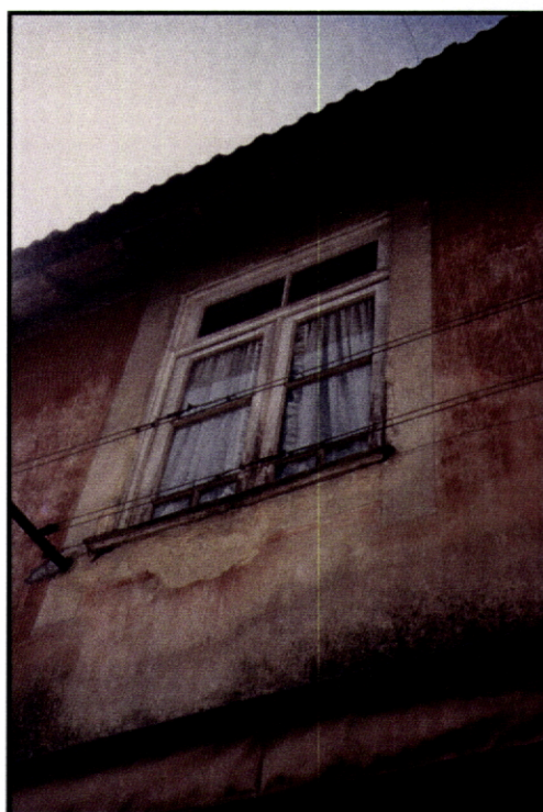
Fig. 98 – Mondim de Basto. Cantaria de janela fingida. Sobre a parede foi aplicada uma tinta à base de cal e de óxido de ferro.
