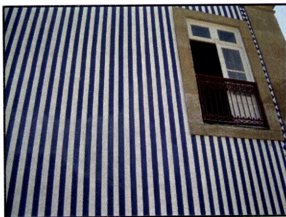
Fig. 77 - Casa do Barão. Cabeceiras de Basto. Fachada lateral pintada a simular o padrão de azulejo.
