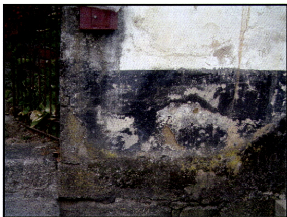
Fig. 113 – Quinta dos Machados. Celorico de Basto. Alizar guarnecido a cinzento (pó de sapato).
