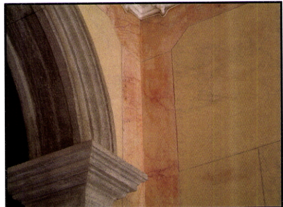
Fig. 174 - Hospital Termal das Taipas. Átrio. A simulação dos veios foi executada por pintura a fresco.
