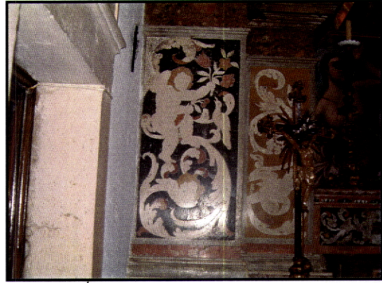
Fig. 67 Ihavo. Capela da Vista Alegre. Séc. XVII. Painéis em mármore embutidos rematados a brecha da Arrábida.
