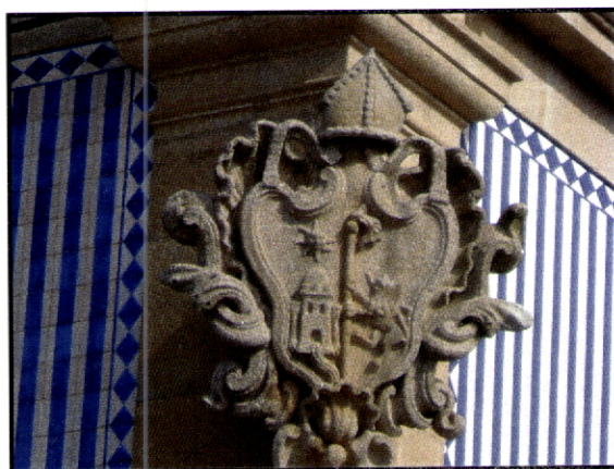
Fig. 78 - Casa do Barão - Cabeceiras de Basto. Neste cunhal, visualiza-se o encontro da fachada revestida a azulejo e da fachada em pintura mural.
