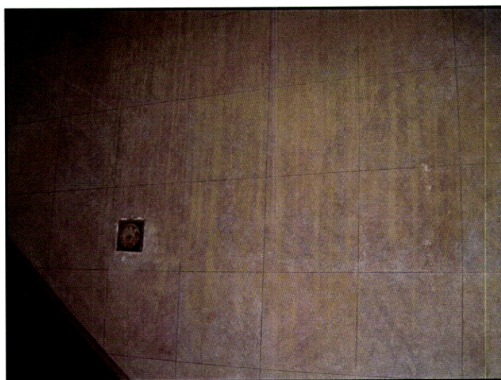
Fig. 144 – Casa de Eiró de Baixo. Mondim de Basto. Parede revestida em técnica de stucco-lustro . Pormenor da marcação da esterotomia do mármore. Esta marcação era realizada com o estuque ainda fresco por meio da régua de cantos.
