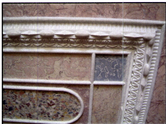
Fig. 136 – Palacete Abrunhosa. Viana do Castelo. Pormenor da aplicação de gessos embutidos, de várias cores a forrar o paramento.
