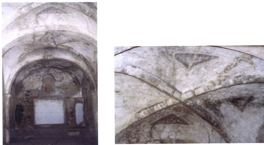
Fig. 4.198 – Moura, Convento de N. Sr.ª da Assunção do Castelo, compartimento (6) abobadado (revestimento em estudo) (foto da autora) Fig. 4.199 - Idem , abóbada com revestimento a simular pedra através de pintura das juntas (foto da autora)
