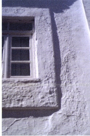
Fig. 4. 233 - Moura, Bairro da Mouraria, casa com moldura bem evidenciada no paramento (foto da autora)
