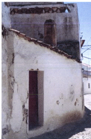
Fig. 4. 237 - Moura, Bairro da Mouraria, casa com degrau todo caído (foto da autora)
