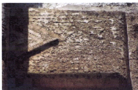
Fig. 4.180 – Moura, Convento de Nossa Sr.ª da Assunção do Castelo, parede da entrada principal, diferenciação de cores aplicadas nos medalhões. (foto da autora)
