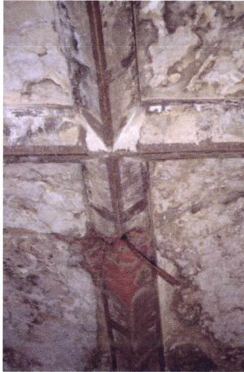
Fig. 4.201 – Moura, Convento de Nossa Sr.ª da Assunção do Castelo, revestimento sobre alvenaria de tijolo (foto da autora)
