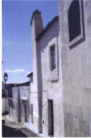
Fig. 4. 218 - Moura, Bairro da Mouraria, casa sobradada com chaminé de ressalto ( foto da autora)
