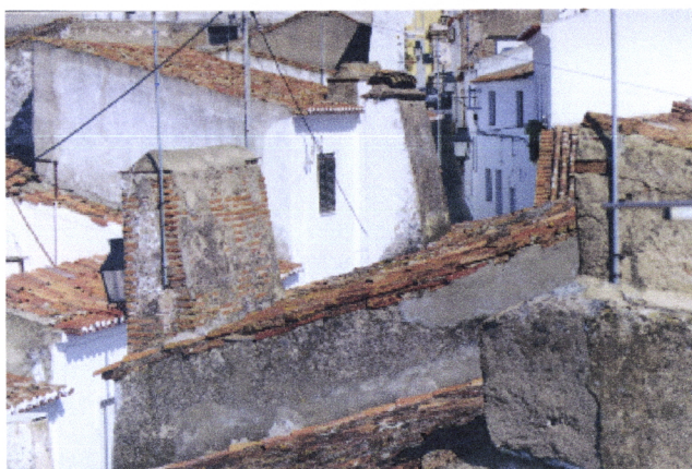
Fig. 4.246 - Moura, Bairro da Mouraria, chaminé concretizada em alvenaria de tijolo (foto da autora)
