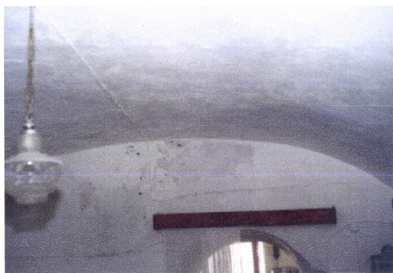
Fig. 4. 241 – Moura, Bairro da Mouraria, casa com abóbada de berço. (foto da autora)
