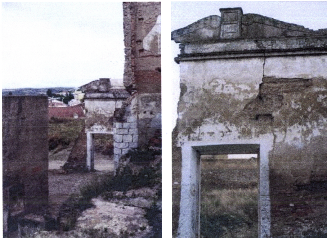
Fig. 4.185 - Castelo/ Convento de Nossa Sr.ª da Assunção, enquadramento da parede da entrada principal (foto da autora)
