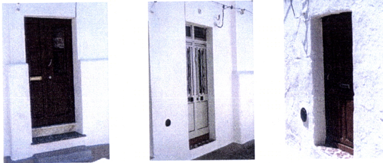
Fig.4.270, Fig. 4.271 e Fig. 4.272 – Moura, Bairro da Mouraria, casa com soleiras e peitoris descon- textualizados (fotos da autora)
