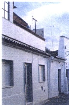
Fig.4.268– Moura, Bairro da Mouraria, casa com cantaria em pedra (foto da autora)
