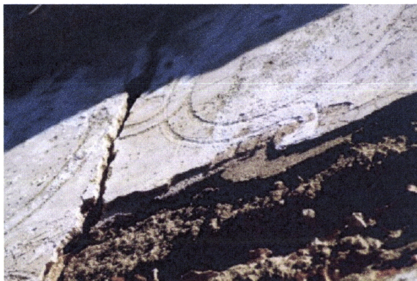
Fig. 4.192 e Fig. 4.193 – Moura, Convento de Nossa Sr.ª da Assunção do Castelo, pormenor das camadas constituintes do revestimento interior da parede da entrada principal (fotos da autora)
