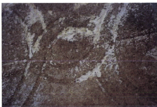
Fig. 4.194 e Fig. 4.195 – Moura, Convento de Nossa Sr.ª da Assunção do Castelo, visualização do processo de aplicação do desenho no revestimento. (fotos da autora)
