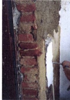
Fig. 4.230 - Moura, Bairro da Mouraria, uso do tijolo na abertura de vãos (foto da autora)
