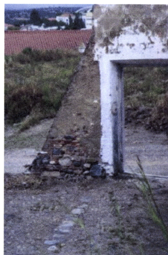
Fig. 4.190, Fig. 4.191 – Moura, Convento de Nossa Sr.ª da Assunção do Castelo, materiais constituintes da parede – taipa e alvenaria de pedra irregular (fotos da autora)
