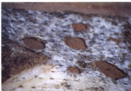
Fig. 4.179 – Moura, Convento de Nossa Sr.ª da Assunção do Castelo, parede da entrada principal, pormenor da camada fina de revestimento que cobre o medalhão (foto da autora)
