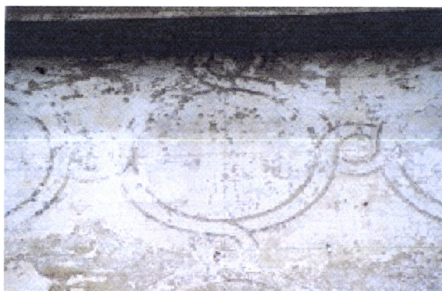
Fig. 4.187 - Moura, Convento de Nossa Sr.ª da Assunção do Castelo, revestimento (esgrafito) (foto da autora)
