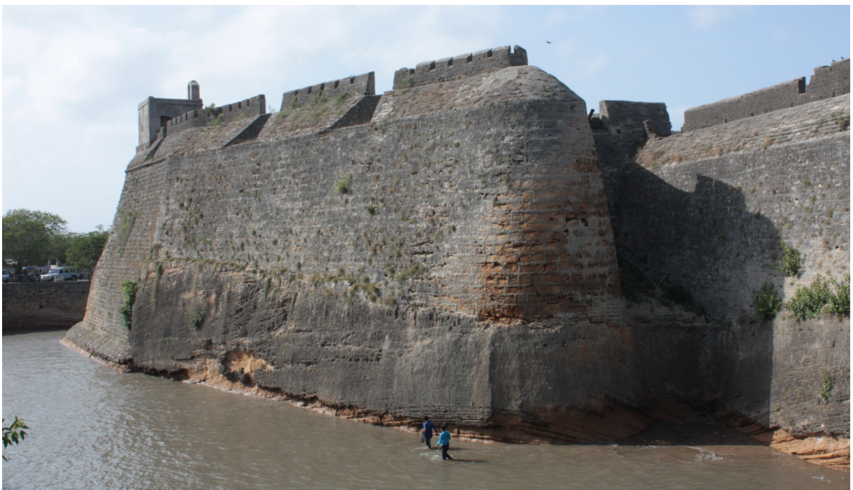
FOT. 58 - Baluarte de São Domingos vista Poente
