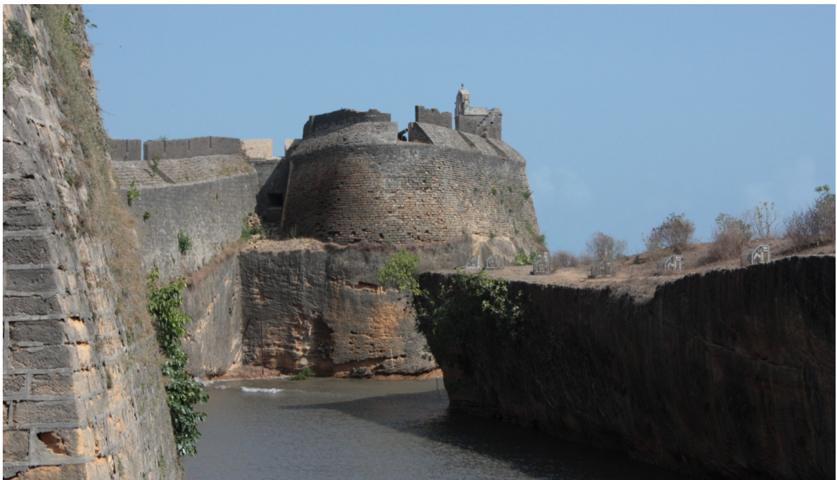
FOT. 49 - Baluarte de São Nicolau vista ponte
