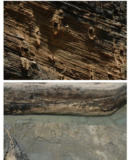
FOT. 47 e 48 - Segundo fosso fortaleza Podem ser observados os resultados das superfícies, após a extracção da pedra na abertura do fosso
