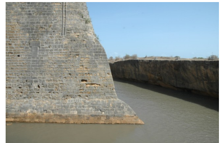
FOT. 57 - Baluarte de São Domingos Construção em pedra, que se estende até ao sopé do baluarte
