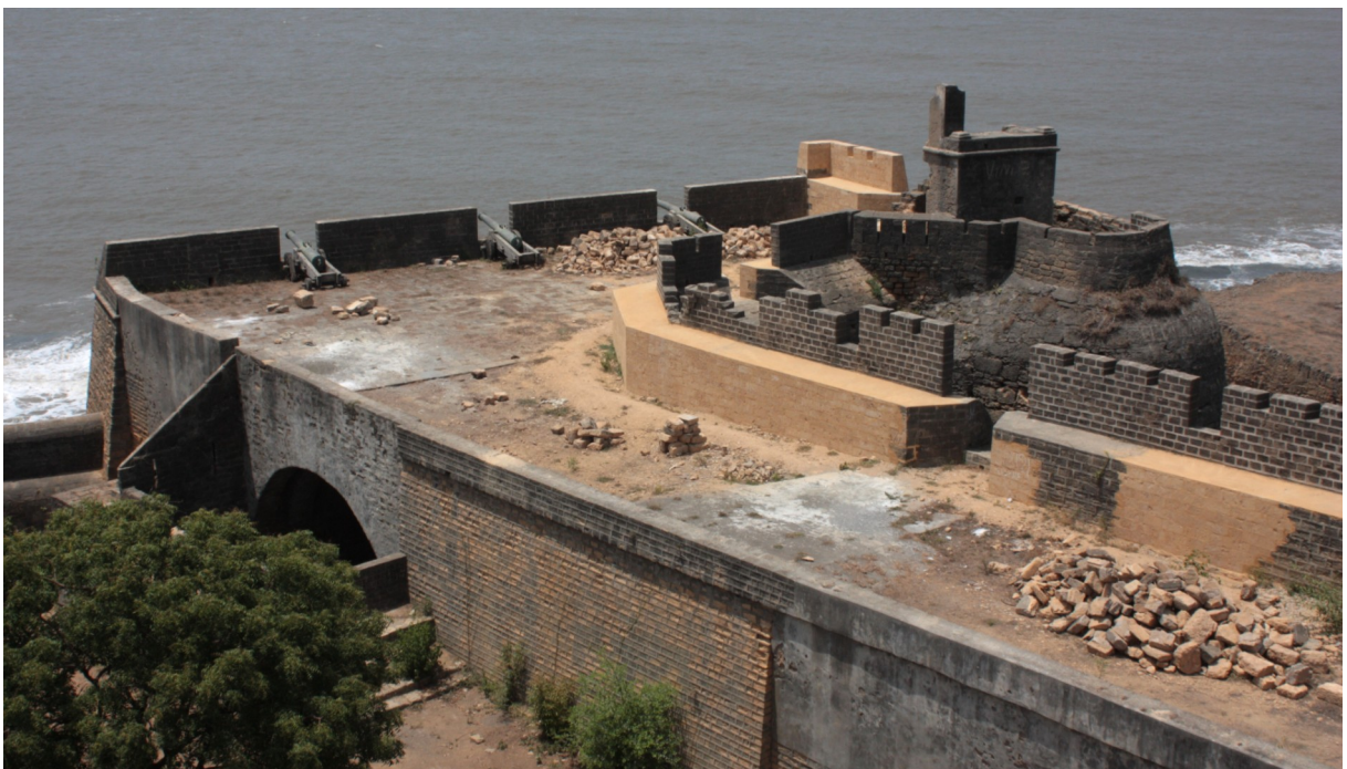
FOT. 55 - Baluarte de São Filipe vista cobertura
