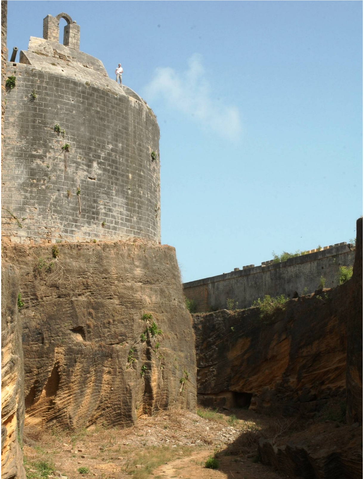
FOT. 41 - Baluarte de Cavaleiro
