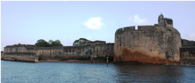
FOT. 40 - Baluarte de São Jorge , vista Norte
