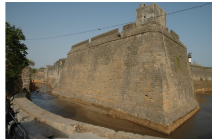
FOT. 56 - Baluarte de São Domingos Fosso e antefosso
