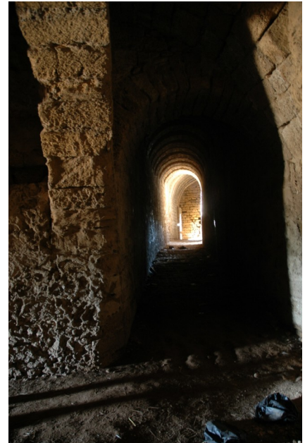
FOT. 59 - Baluarte de São Domingos casamata Norte e túnel para a casamata Sul
