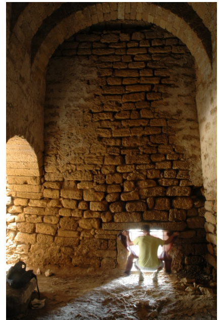
FOT. 50 - Baluarte de São Nicolau , Casamata Sul
