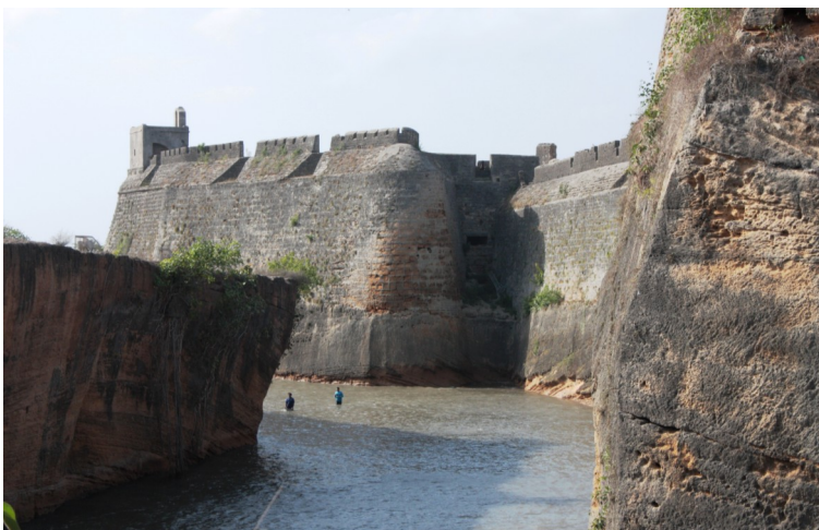
FOT. 28 - Fosso exterior da Fortaleza
