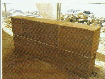
Figura 5 – Processo construtivo da taipa (retirado de COSTA (2008), p. 73.)
