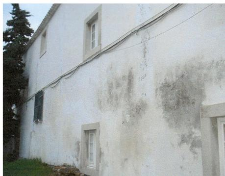
Figura 8 – Degradação da pintura de acabamento de uma parede da fachada.
