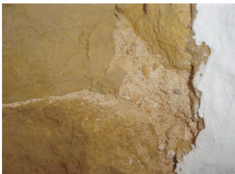
Figura 7 – Degradação do reboco de uma parede do Claustro.
