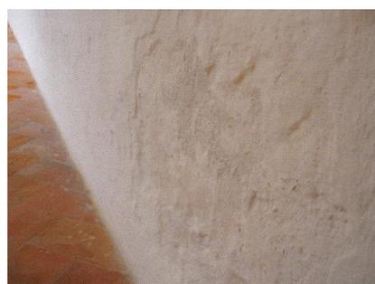
Figura 6 – Eflorescências na base de uma parede do Claustro provocadas pela humidade ascensional.
