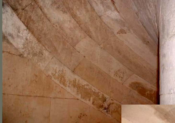
Abóbada de S. Gilles próximo de Arles.
