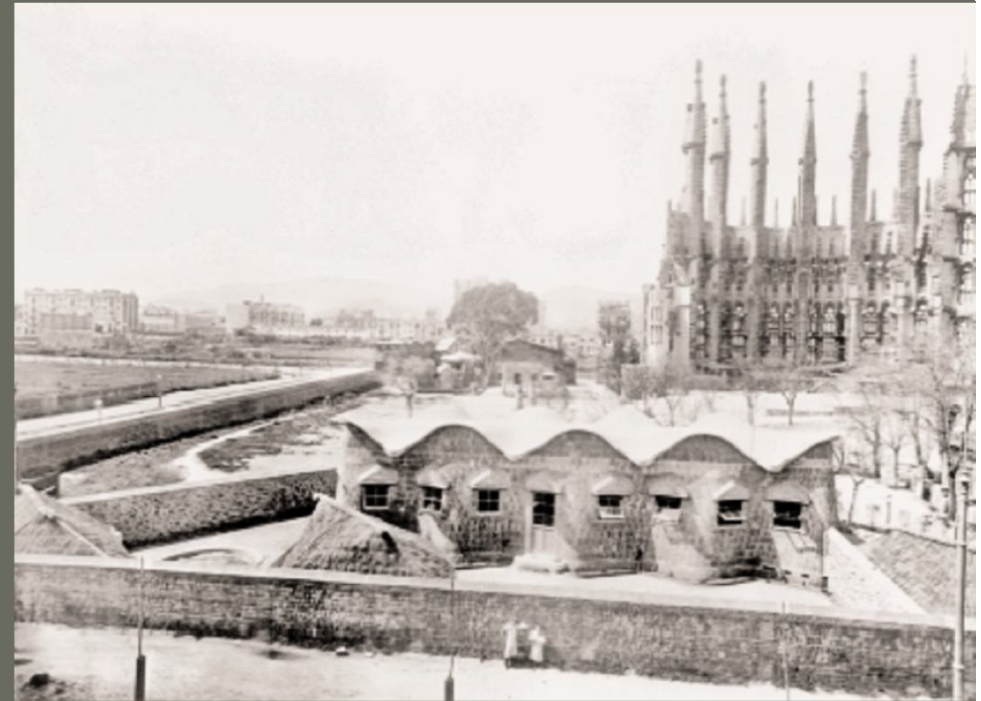
Conóides da cobertura e dos muros das Escolas Provisionais da Sagrada Família.
