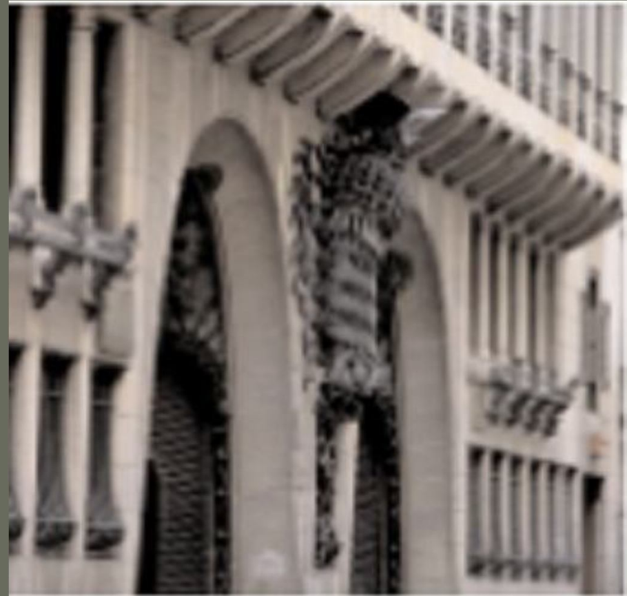
Um dos primeiros arcos de perfil aproximadamente parabólico de grandes dimensões da obra de Gaudí, no Palácio Güell- Fonte: © Robert FERRÉOL , Jacques MANDONNET 2005
