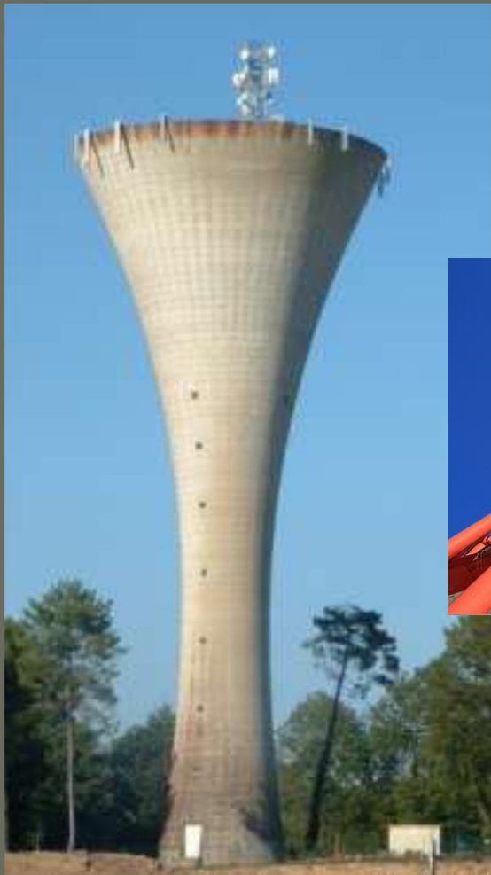
Castelo de água (próximo de Vannes).
