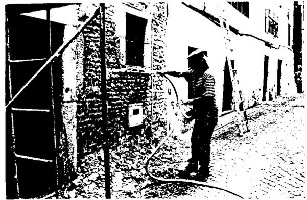
fig.89- Lavagem das paredes com água para eliminação de sujidades.
