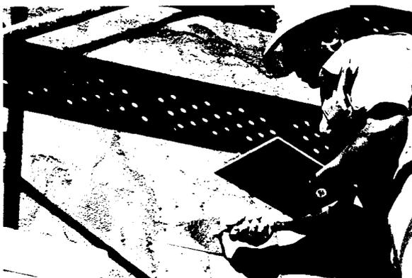
fig. 94- Aplicação da camada de acabamento à colher.
