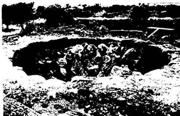
fig. 12- Cal viva em pedra dentro do forno após a combustão.
