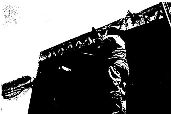
fig. 92- Aplicação à colher da camada do emboço directamente sobre a alvenaria.
