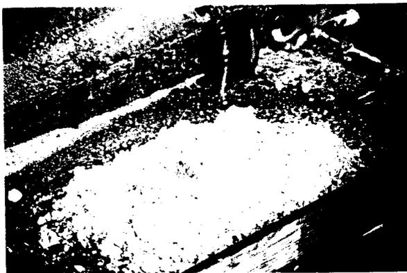
fig. 80- Processo de extinção da cal viva branca do forno tradicional de Montes Claros.
