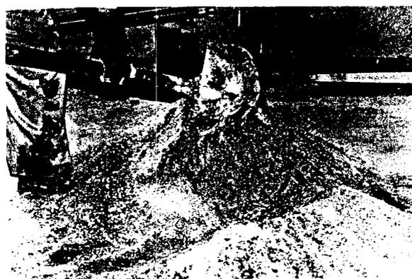
fig. 83- Mistura dos materiais a seco com uma pá.
