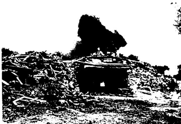
fig. 8- O final da combustão é detectado quando o fogo começa a sair pelos "olhais", a fotografia mostra o fogo a ser expelido ainda apenas por uma abertura.
