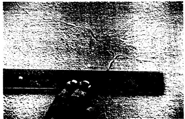
fig. 102- Pormenor da fissuração dos revestimentos.
