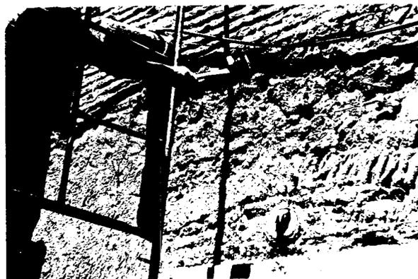
fig. 91- Molhagem das paredes antes da aplicação das argamassas.
