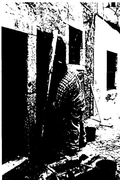
fig. 93- Regularização da camada do emboço à régua. A fotografia mostra-nos a aplicação de uma camada de emboço sobre uma primeira camada que já tinha sido aplicada e se encontrava seca.
