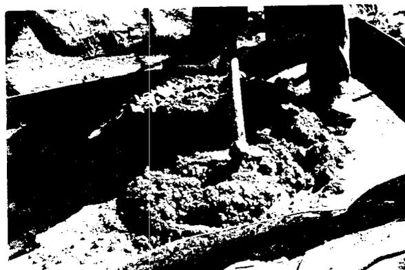
Fig. 85- Mistura da argamassa com uma enxada até obter uma pasta homogênea.
