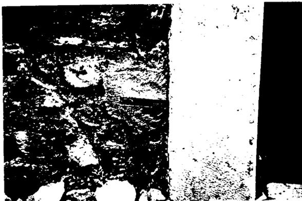
fig. 90- Pontos executados com argamassa e um fragmento de tijolo para servirem de guias na aplicação dos revestimentos.
