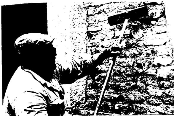
fig. 88- Escovagem da alvenaria com uma escova de arame para eliminação de argamassas soltas.
