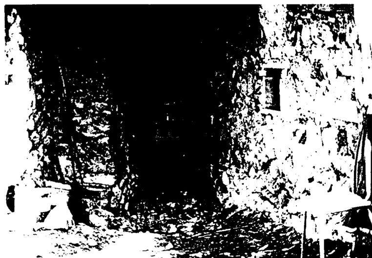
fig. 5- Abertura do forno preenchida pelo mármore de Trigaches, deixando um pequeno espaço para a introdução da lenha durante o processo de combustão.
