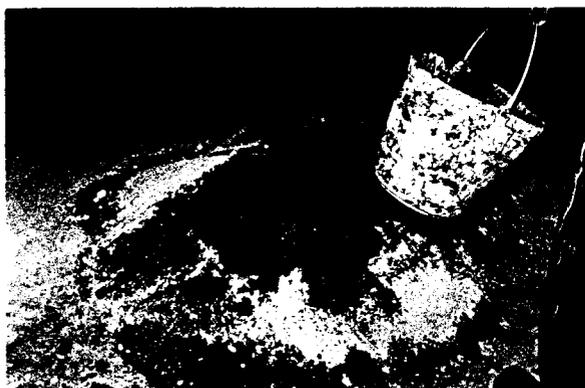
fig. 82- Junção da cal à areia por camadas para a execução da argamassa.
