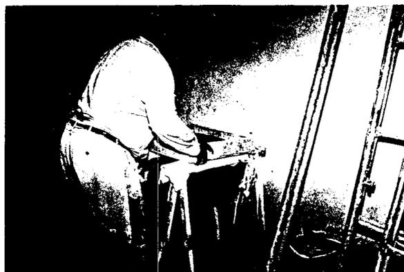
fig. 81- Passagem da areia por um peneiro de 2 mm para a execução das camadas de acabamento.
