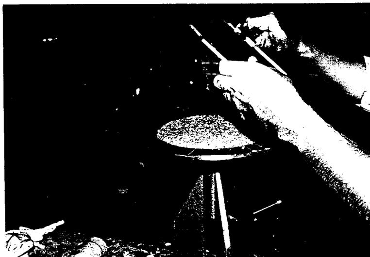
fig. 46- Medição da consistência por espalhamento.
