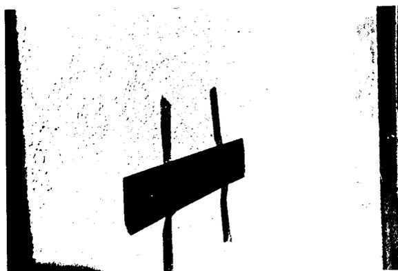
fig. 96- Pormenor das fissuras na parte do paramento onde foram aplicados os traços C+D.
