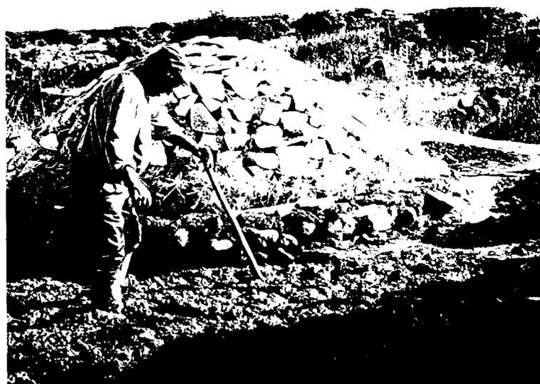
fig. 6- Armação em pedra do forno completa e preparação do barro, ainda por um processo tradicional sendo visível a amassadura com os pés, para tapar a abóbada.
