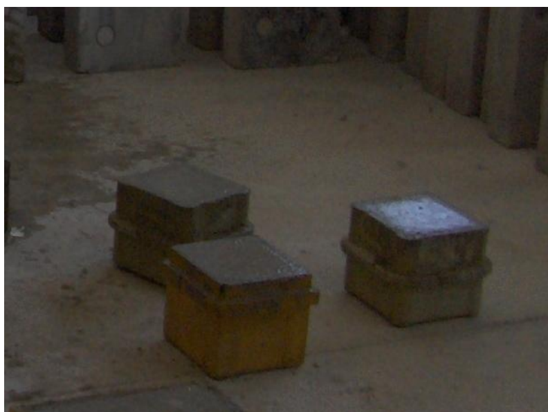
Figura 3.18 – Provetes de controlo, recém-betonados
