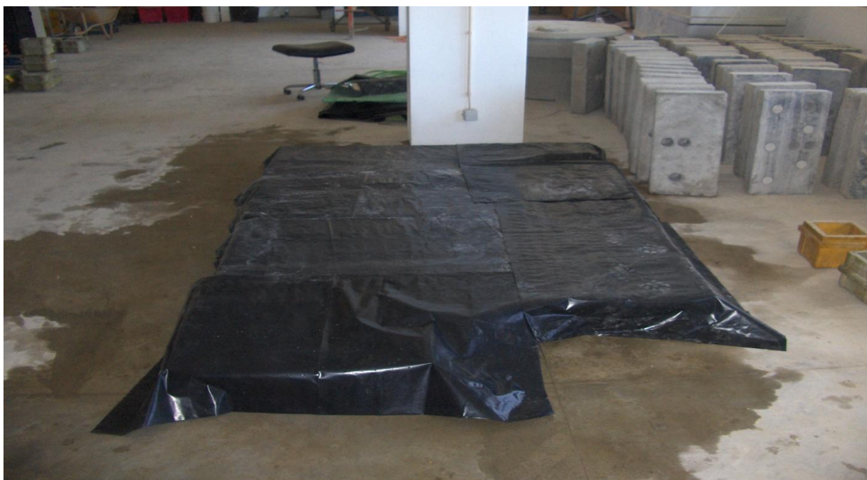
Figura 3.21 – Cobertura das lajetas com sacos de plástico
