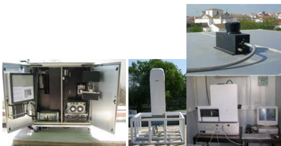
Figura 3.2 - Instrumentos em terra de detecção remota instalados no CGE (da esquerda para a direita): LIDAR, Ceilómetro e espectrómetro SPATRAM.
