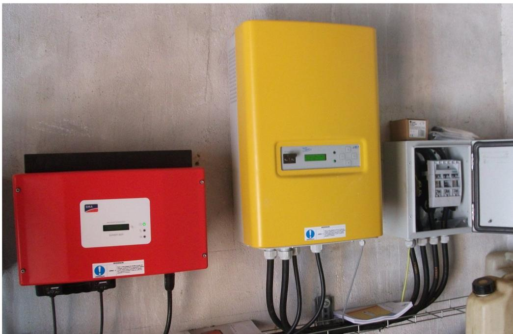
*Figura 3. Sistema de inversores necessários para o armazenamento de energia em baterias*
