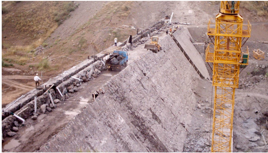
Figura 7. Construção da barragem do Poilão em 2005.
