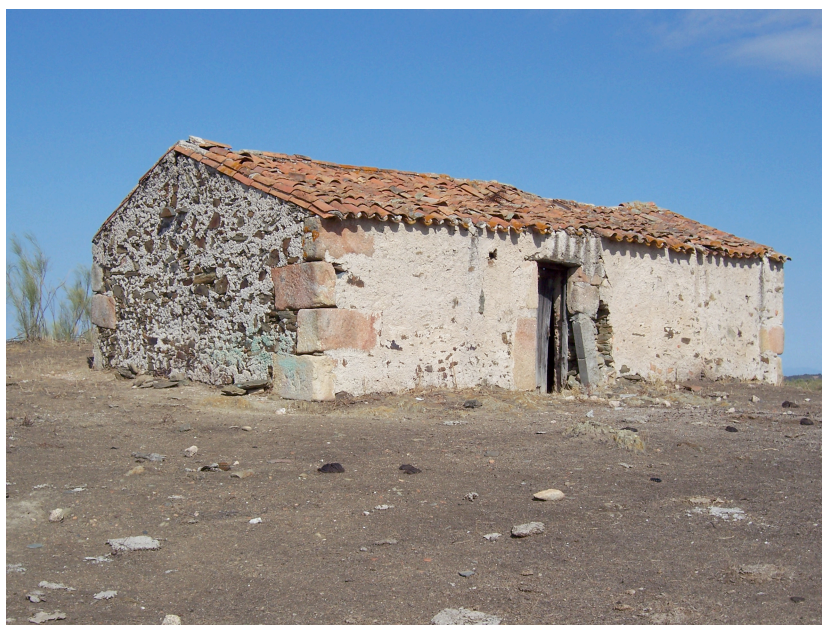
Casão da Machouqueira (06.04): elementos reaproveitados em casão agrícola
