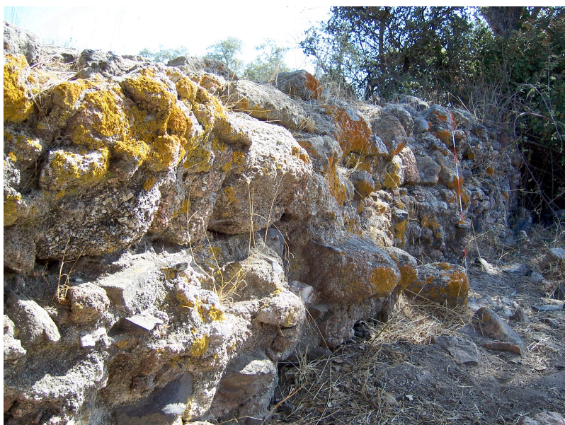
Tapada Grande (06.10): vista do paredão da barragem.
