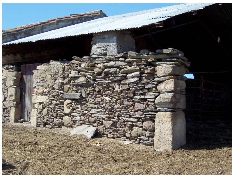
Casão do Leandro (06.02): elementos reaproveitados em casão agrícola.
