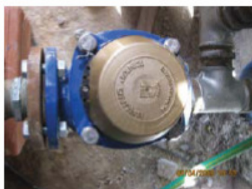
37 – Contador do Furo do Campo da Bola
