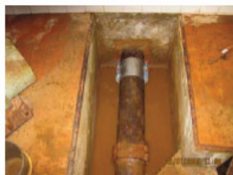
23 – Reparação de Rotura no Reservatório das Techocas
