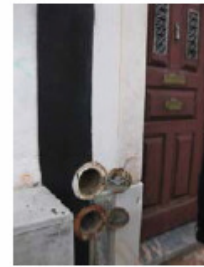
12 – Válvula de corte “tipo” em Ramal de Ligação a cliente da Cidade de Estremoz
