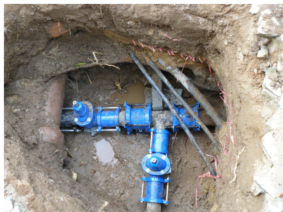
Figura 25- Substituição por válvulas de cunha
