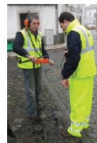
21 – Escuta após fecho Válvula do Largo do Gadanha
