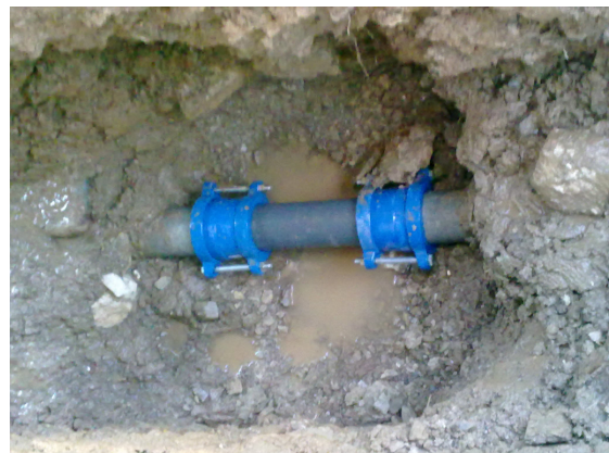
Figura 20-Substituição das uniões simplex por juntas multimateriais em ferro fundido revestidas a resina epoxi
