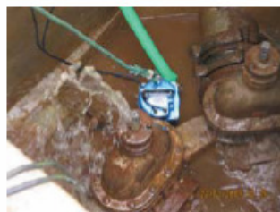
24 – Esvaziamento da caixa da Forquilha de saída das Captações das Techocas para reparação
