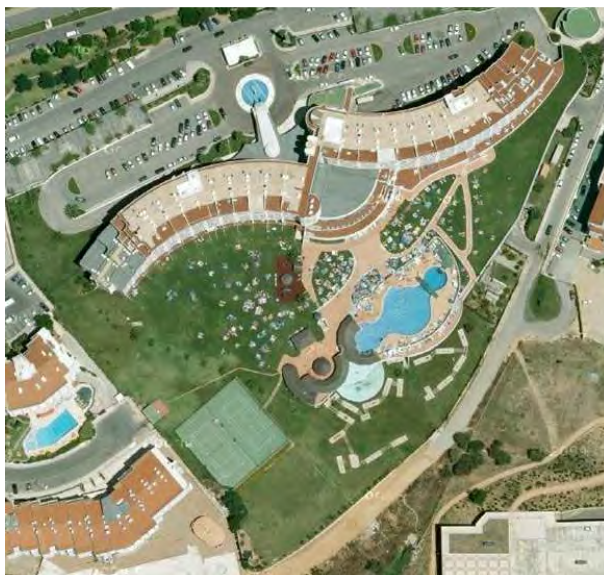
Figura 6.10 – Vista aérea do Aparthotel "GC002".
