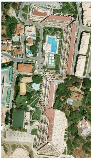
Figura 6.13 – Vista aérea do Aparthotel "GC005".
