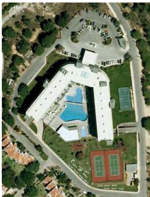
Figura 6.16 – Vista aérea do Aparthotel "GC023".
