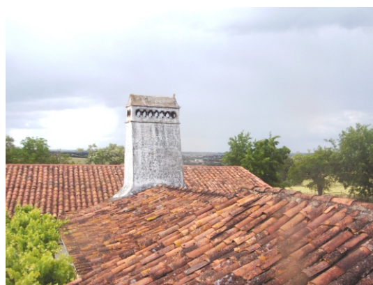
Chaminé da casa da malta
