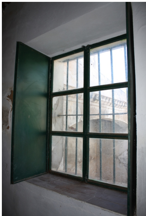
Fachada Sudoeste do monte , com presença de grades salientes de protecção das janelas e vista do interior (2013) ©Sílvia Teles
