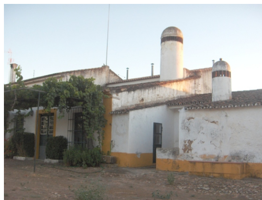
Chaminés . Fachada Sudoeste de entrada do proprietário
