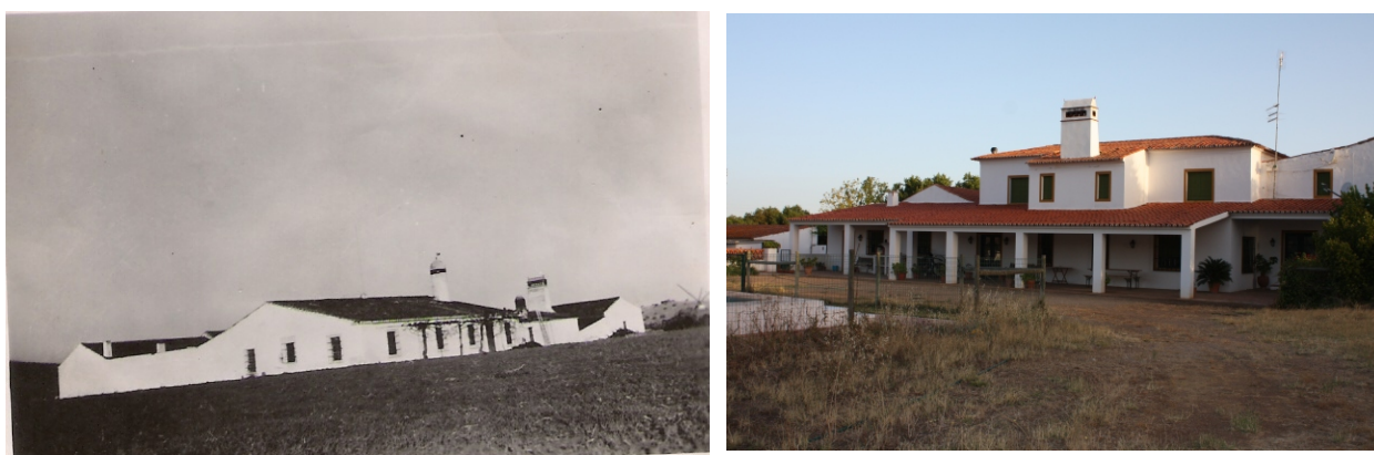
(Fotografias de cerca de 1960/70, presente no Inquérito à Arquitectura Popular Portuguesa e fotografias actuais. (2013) ©Sílvia Teles Pátio e fachada (ala com a habitação do pastor e queijaria, que viviam para o pátio | actualmente a fachada abre-se no sentido oposto ao de pátio e funciona como habitação do proprietário Dr. António da Mata Antunes).
