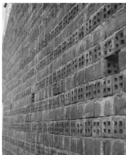
Paramentos de tijolo não rebocados, imagem presente in AA.VV., (1988), Arquitectura Popular em Portugal , volume III (zona 5: Alentejo, Zona 6: Algarve), p.42
