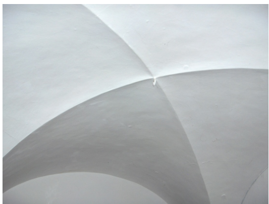
Cobertura em abobadilha num dos quartos. Nota-se ainda o pequeno elemento de suporte dos candeeiros a óleo. (2013) © Sílvia Teles
