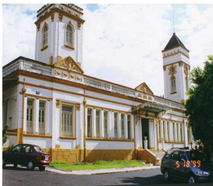
FIGURA 01 - Fachada frontal do edifício, onde são vistas as janelas amplas, as calhas e os elementos decorativos em estilo neoclássico.
