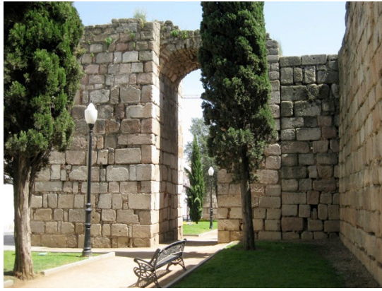
Fig. 13 – torre albarrã, encostada a torre do projecto original
