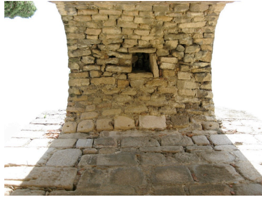
Fig 14 – orifício no passadiço de ligação entra a muralha e a tore albarrã, para ataque na vertical.
