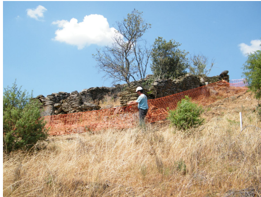
Figura 35 - Exemplo das vedações patrimoniais realizadas durante a empreitada.
