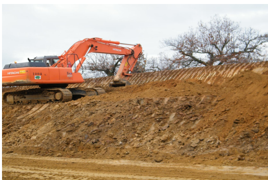
Figura 24 - Perfilamento de taludes ao Pk1+150m (esquerda). Figura 25 - Decapagem no sítio nº 45 Olival Grande (direita).
