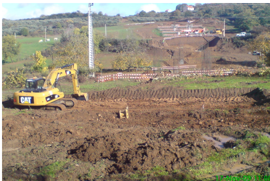
Figura 20 - Escavação do pilar 6 (P6) do viaduto 1 (V1) ao Pk 1+954.50 m (esquerda). Figura 21 - Decapagem mecânica entre o Pk 10+350m e o Pk 11+000m (direita).
