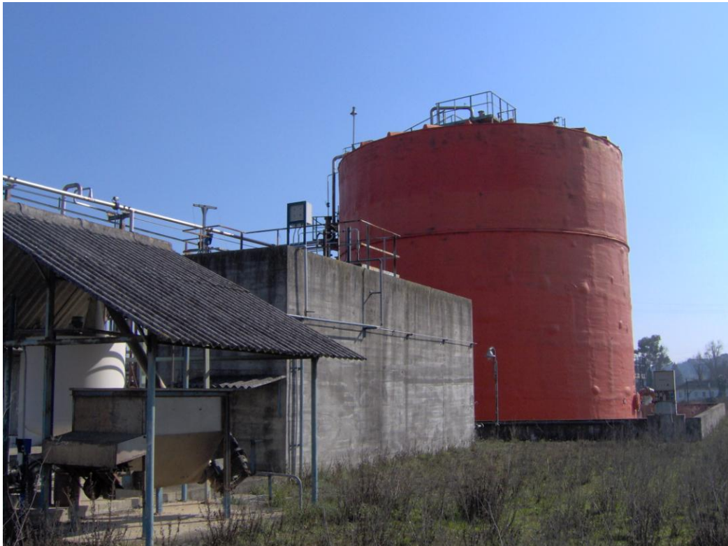
Figura 39 – Vista geral da estação de tratamento.
