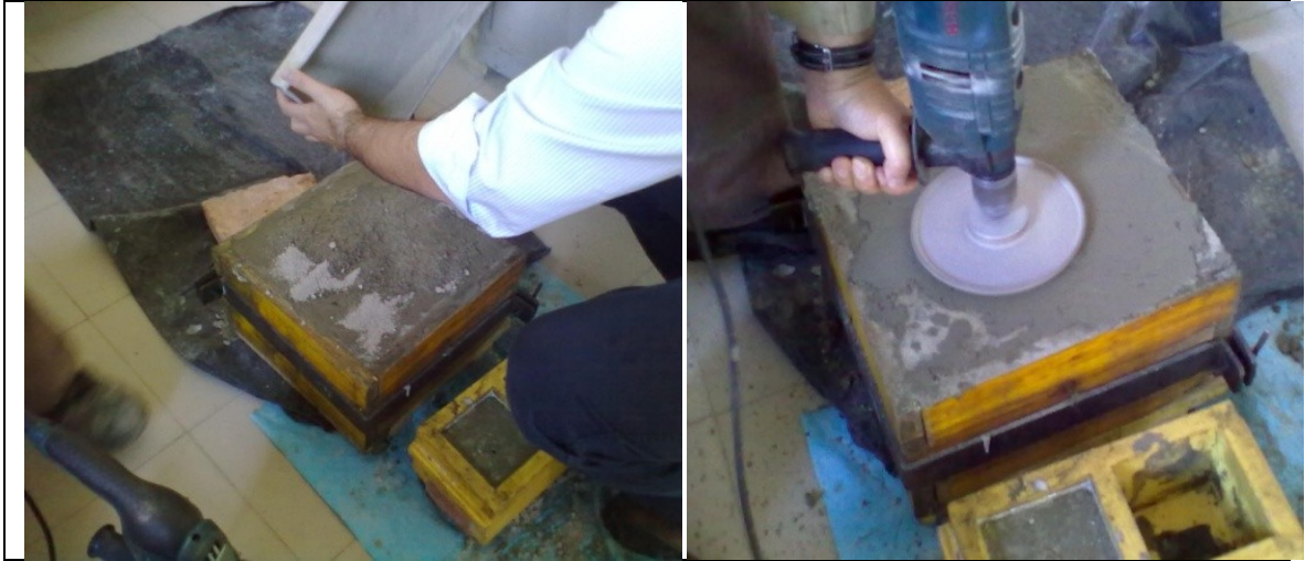
Figura 43 - Aplicação do Endurecedor e afagamento da lajeta
