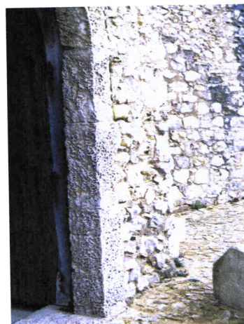
II. 40 – Cabo S. Vicente (Portugal): Erosão alveolar na cercadura de cantaria.
