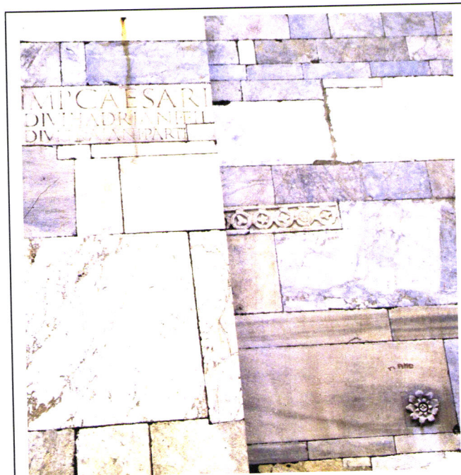
Il. 37 – Pisa (Itália): Reaproveitamento de pedras de antigos edifícios romanos na cantaria da Catedral.
