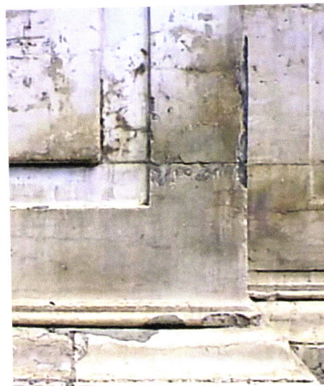
Il. 45 – Salvador (Bahia, Brasil): (a) Reintegrações inadequadas com uso de argamassa de cimento tipo Portland, na base do portal da Igreja da Venerável Ordem 3 a de S. Francisco (séc. XVIII). (b) Idem, na fachada da Igreja do Colégio de Jesus (séc. XVII), actual Catedral Basílica.
