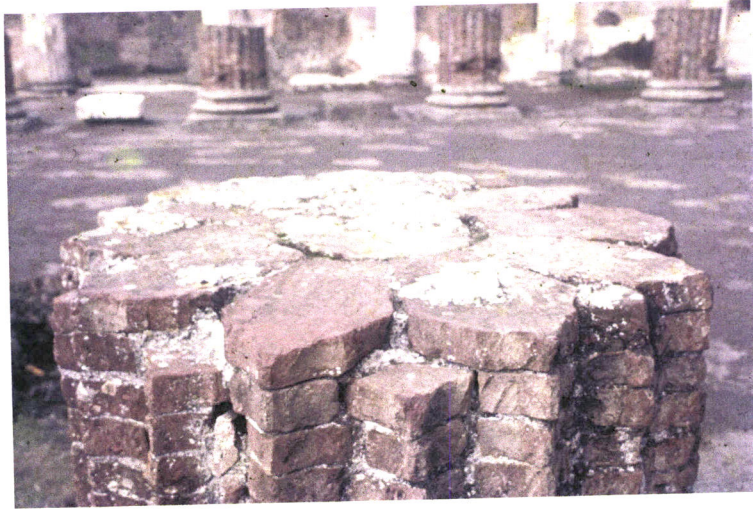
Il. 13 – Roma (Itália): Resto de fuste de coluna dórica no Forum Romano, com tijolos especiais para o arremate das caneluras em argamassa.
