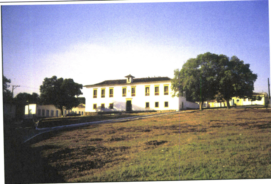
Il. 5 – Goiás Velho (Goiás, Brasil): Casa de Câmara e Cadeia (Séc. XVIII), construída em taipa de pilão.
