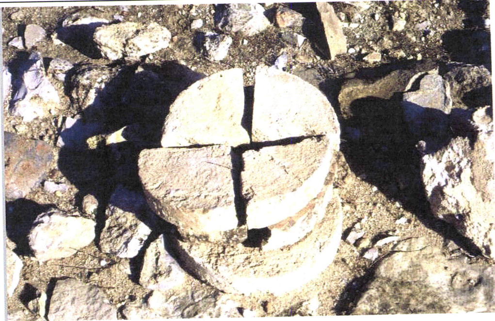
Il. 15 – Milreu (Algarve, Portugal): Tijolos romanos especiais para construção de fustes de coluna.
