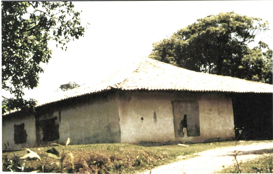
II. 24 (b) – Sítio do Mandú (São Paulo, Brasil): Casa bandeirista construída em taipa de pilão (Séc. XVII).
