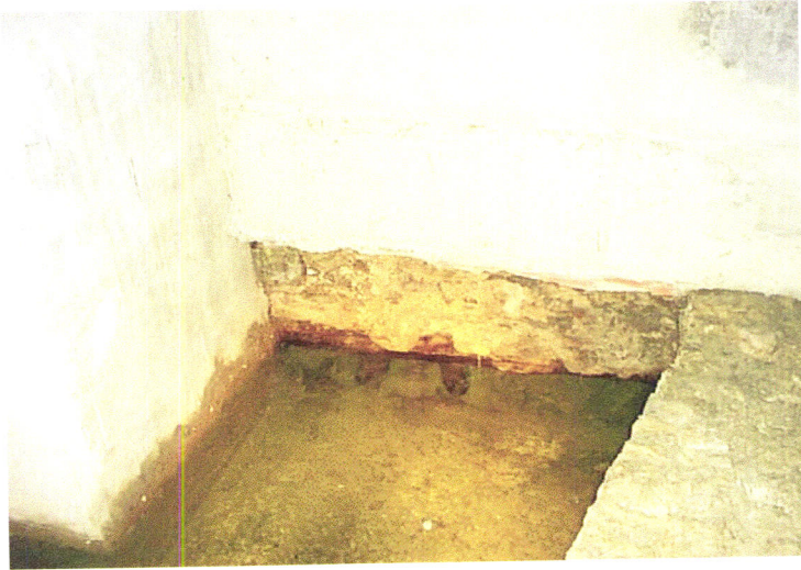
II. 75 (a) - Lisboa (Portugal): Núcleo Arqueológico da rua do Correiros. Evidências de estacas pombalinas, ainda em boas condições, não obstante estarem expostas e dentro da água.
