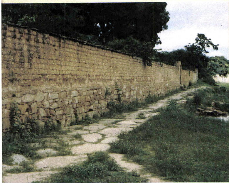
II. 25 – Rio de Contas (Bahia, Brasil): Muro de terra (adobes) protegido com um embasamento de pedra seca.
