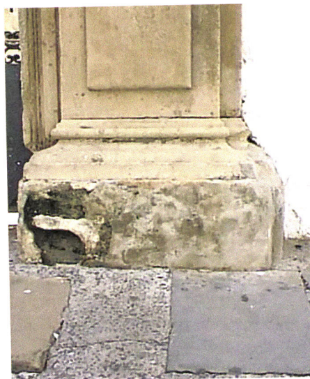
Il. 45 – Salvador (Bahia, Brasil): (a) Reintegrações inadequadas com uso de argamassa de cimento tipo Portland, na base do portal da Igreja da Venerável Ordem 3 a de S. Francisco (séc. XVIII). (b) Idem, na fachada da Igreja do Colégio de Jesus (séc. XVII), actual Catedral Basílica.
