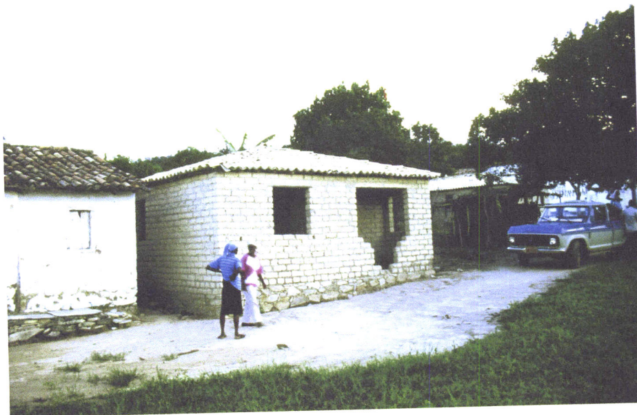
Il. 4 – Bananal (Bahia, Brasil): Construção em adobes artesanais feitos pela proprietária do imóvel. Demonstraram maior resistência do que as telhas cerâmicas de má qualidade que ela adquiriu.
