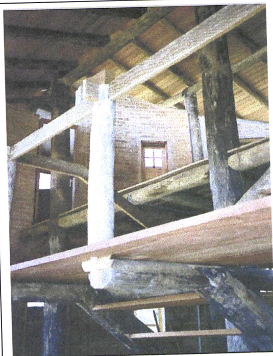
Il. 2(a)– Piracicaba (São Paulo, Brasil): Construção em solo estabilizado da residência Machado (1999). Autores: ArquiTerra.
