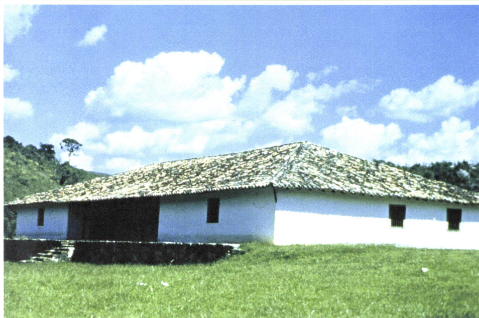
Il. 24 (a) – Estado de S. Paulo (Brasil): Típica casa bandeirista, com varanda a guisa de vestibulo e simetria bilateral na composição da fachada, construída em taipa de pilão.
