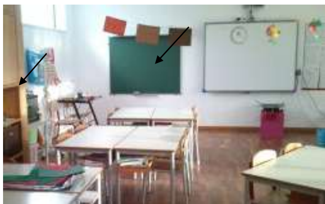
Figura 3 - Fio que atravessa a sala de um lado ao outro
