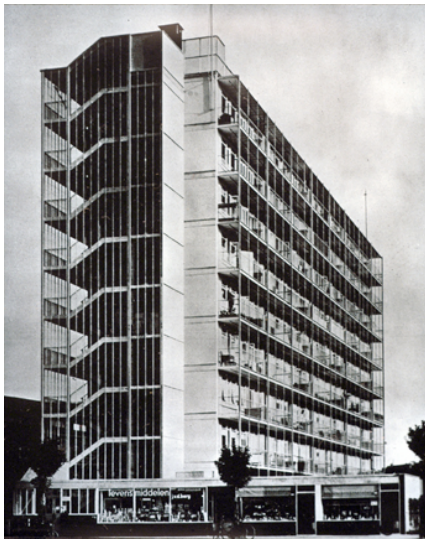
Van Tijen, Brinkman, e Van der Vlugt's, Apartamentos Berpolder, Roterdão, 1932-34.
