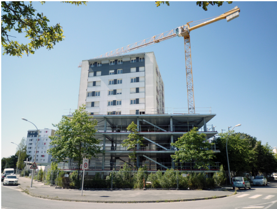
Início do processo de reabilitação do edifício.
