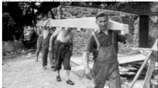
Jean Prouvé, Construção da Casa Prouvé, Nancy - 1952
