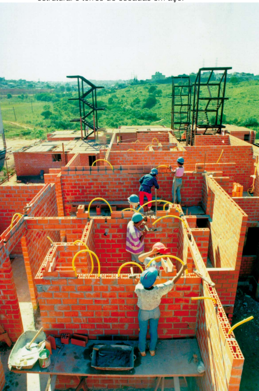
Usina, construção do Mutirão União de Juta, São Paulo, 1994-7. Sistema construtivo misto com alvenaria de tijolo estrutural e torres de escadas em aço.
