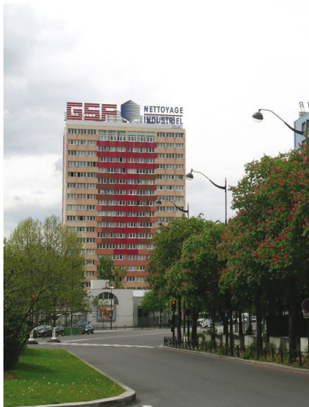
Torre Bois Le Prêtre depois da reabilitação nos anos 90.
