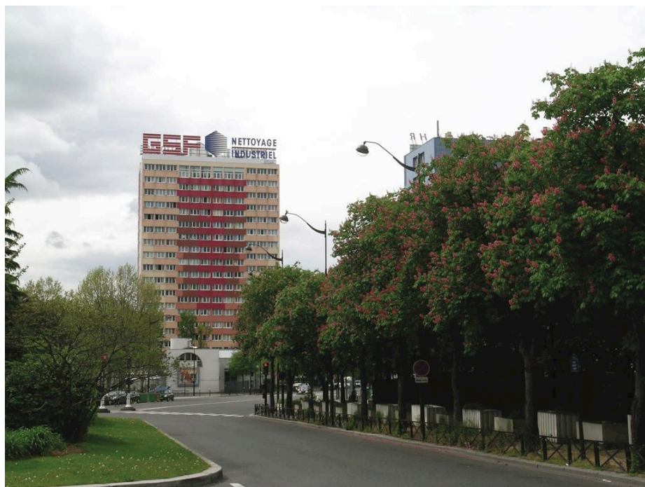
Torre Bois le Petre, Paris, 1961. Antes da Intervenção
