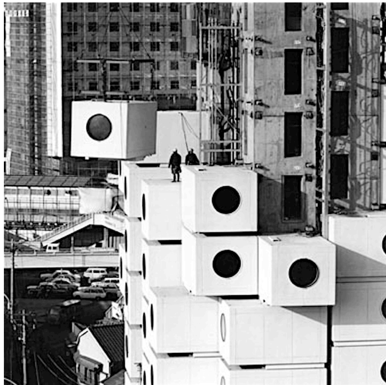
Kisho Kurokawa, Torre Capsular Nagakin, Ginza, Tóquio, Japão, 1970-72. Vista da construção.
