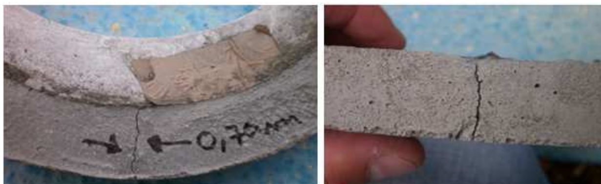
Figura 6.12- Fissuras que atravessam todo o anel
